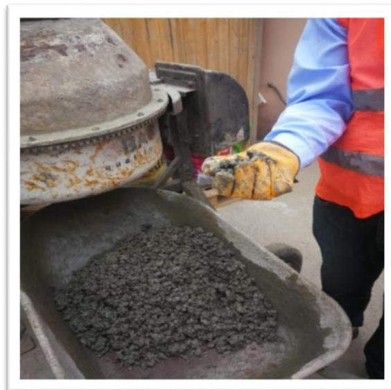
Ilustración 3: Mezcla de concreto permeable
