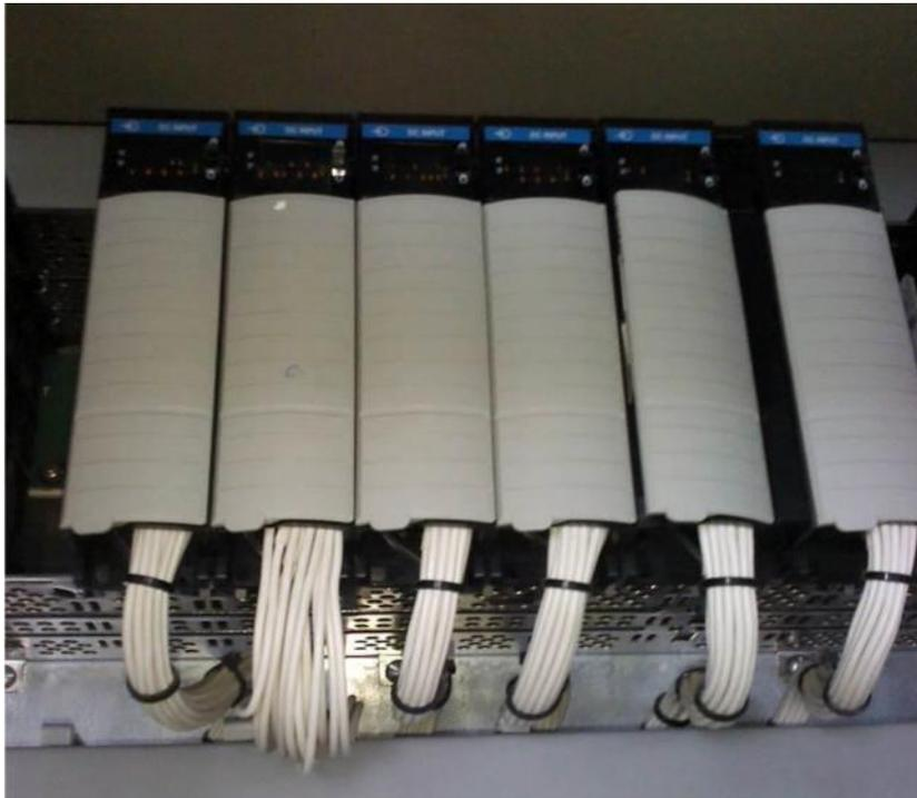
Figura 24: Instalación de modulo E/S análogo digital 2
