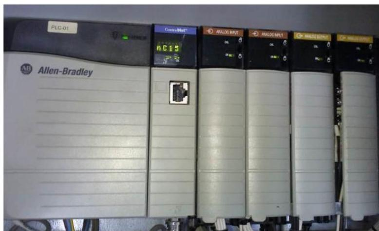
Figura 23: Instalación de modulo E/S análogo digital
