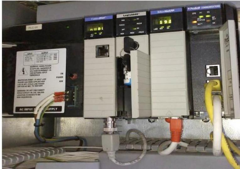
Figura 22: Instalación de módulo de comunicaciones
