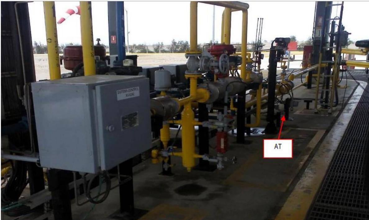
Figura 29: Instalación de Detector de gas
