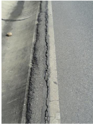
Tramo Individual 11: Pte. Chamaya II - Chamaya Fisuras en Calzada Severidad: Media Km 177+446
