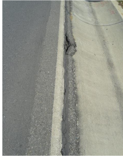
Tramo Individual 11: Pte. Chamaya II - Chamaya Fisuras en Calzada Severidad: Media Km 177+617
