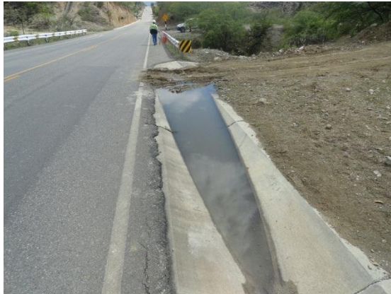
Tramo Individual 10: Cavico – Pte. Chamaya II Obstrucción al Libre Esguimiento Hidráulico en Cunetas Severidad: Alta Km 177+943
