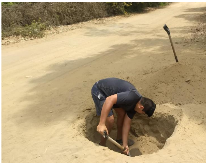
FIGURA N° 12: Excavación manual de calicata
