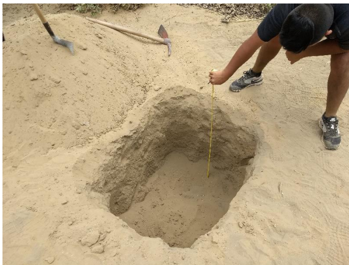
FIGURA N° 11: Toma de medidas de la calicata
