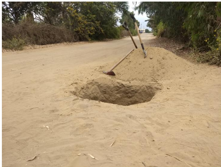
FIGURA N° 10: Calicata ubicada en la vía de acceso a Pampas de San Juan
