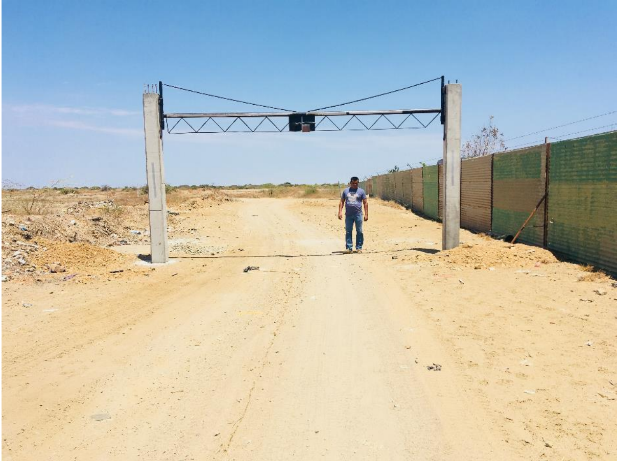
Fotografía 4. Inicio de la zona de estudio, en la vía a la cantera Santa Rita, Progresiva 0+250.
