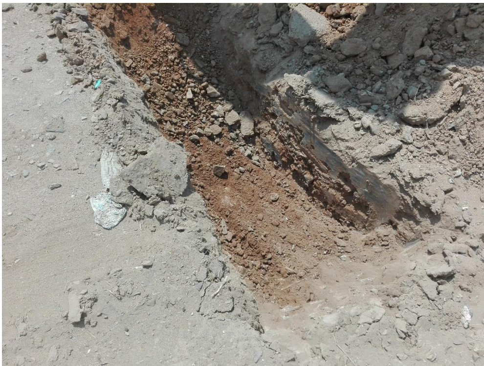
Fotografía 59. Exploración de Campo, excavación con Maquinaria JCB.
