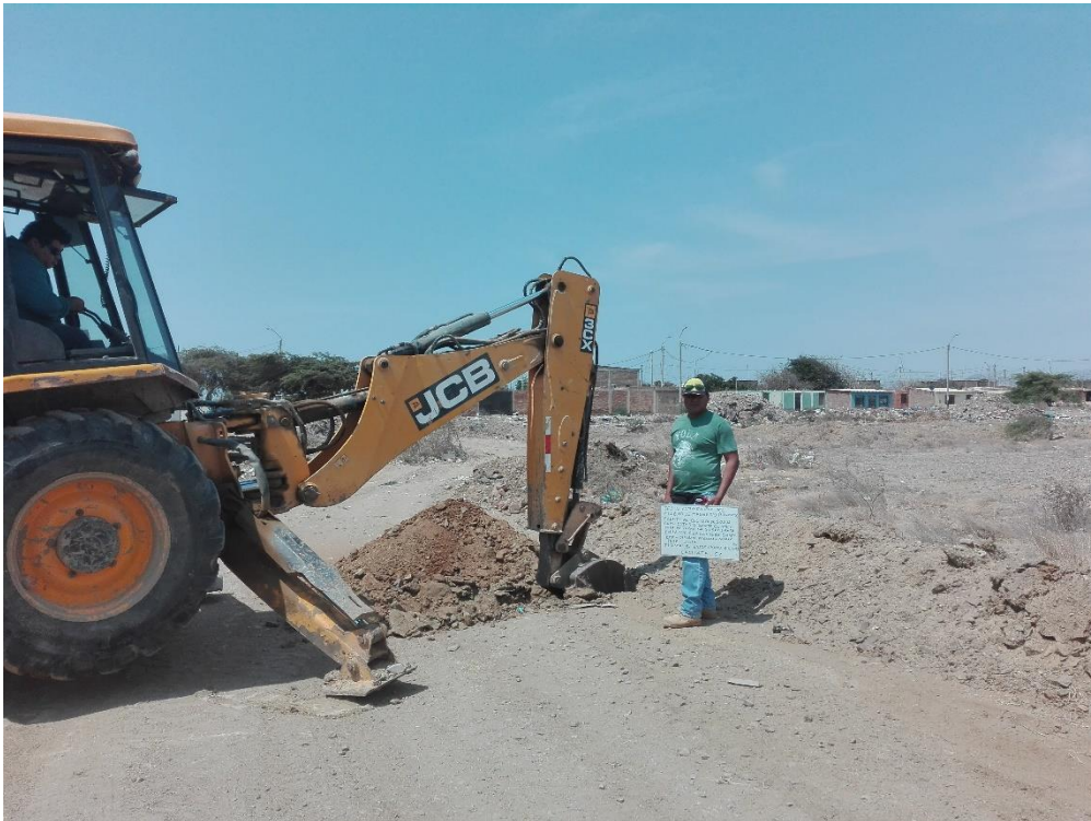
Fotografía 58. Exploración de campo en la progresiva 0+250.
