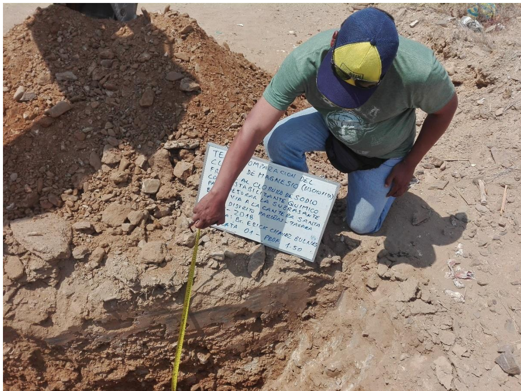
Fotografía 61. Exploración de campo, profundidad de 1.50m.
