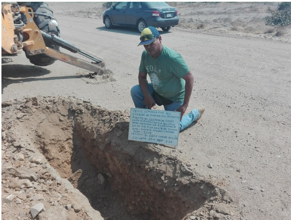
Fotografía 65. Exploración de campo, profundidad de 1.50m.
