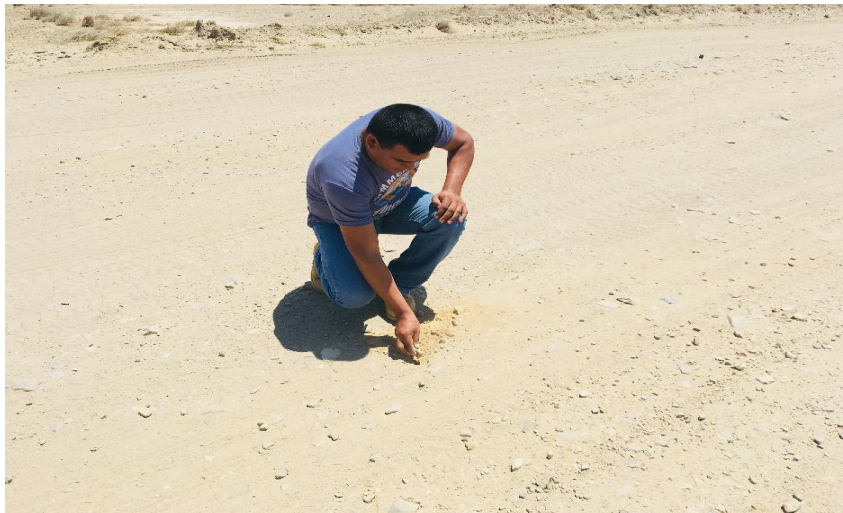
Fotografía 6. Reconocimiento de Campo. Prog. 0+750.
