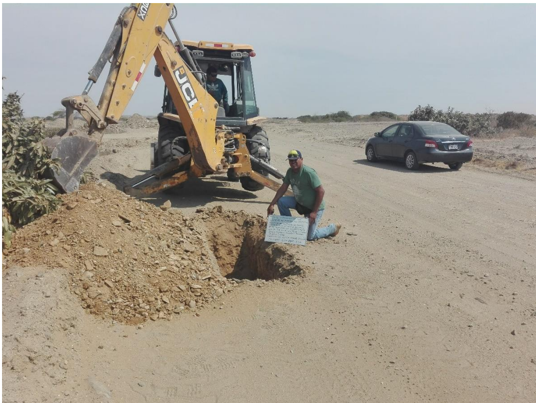
Fotografía 67. Exploración de campo, profundidad de 1.50m.
