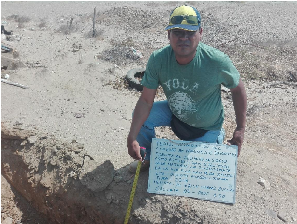
Fotografía 62. Exploración de campo en la progresiva 0+500.
