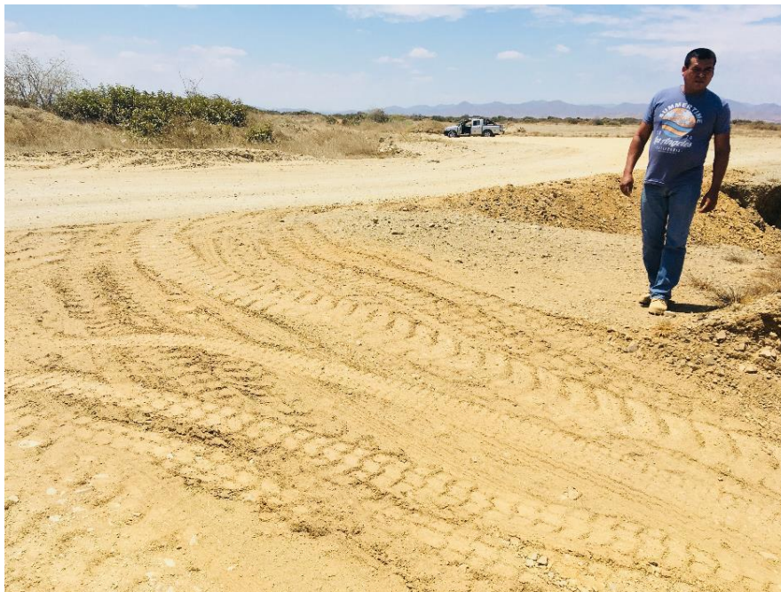
Fotografía 8. Progresiva 1+000. Bajada a la Cantera Santa Rita.
