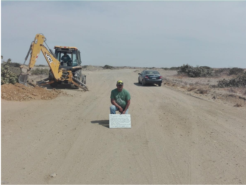
Fotografía 66. Exploración de campo en la progresiva 1+000.
