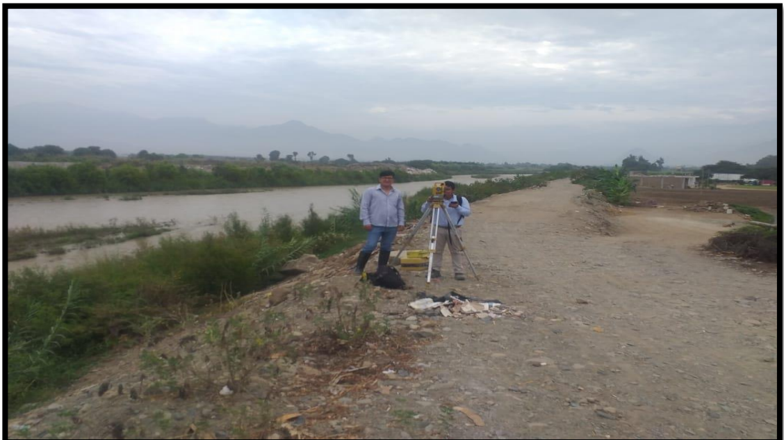
Imagen 16: Instalación del equipo topográfico (Estación Total TOPCON ES105), en el Punto BM.
