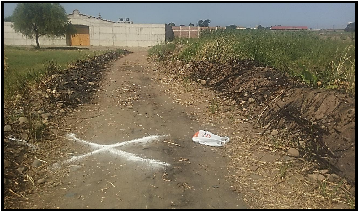
Imagen 13: Puntos de Control en ambos márgenes del río Moche cada 570 m.
