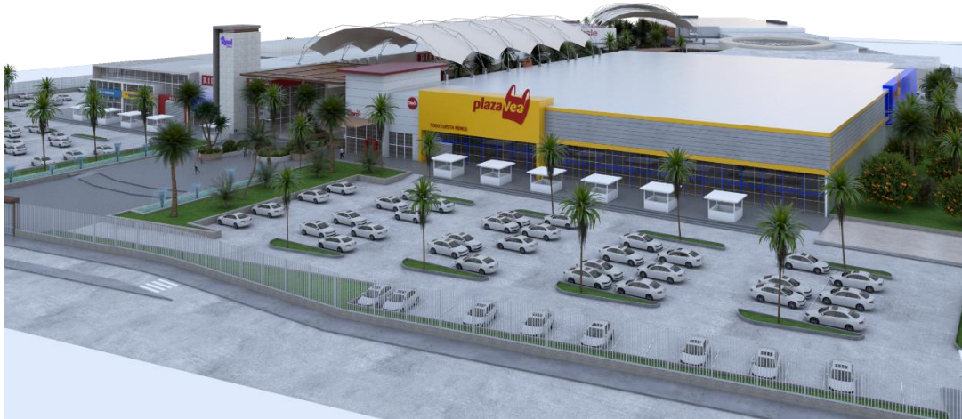
Imagen N° 49: Fachada Principal del Proyecto. Fuente: Elaboración propia
