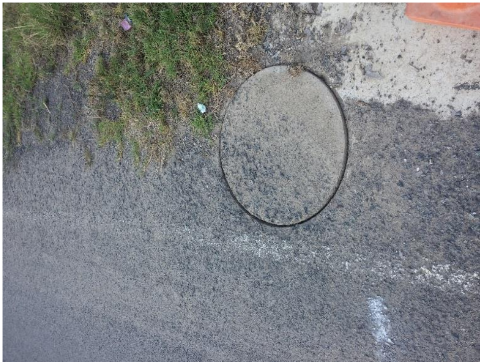
Figura 96: Unidad De Muestra - 49. Parches De Severidad Media.
