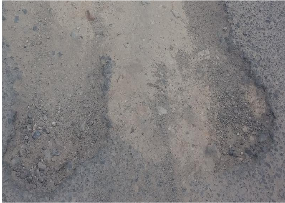
Figura 65: Unidad De Muestra - 18. Tramo Con PCI Regular.
