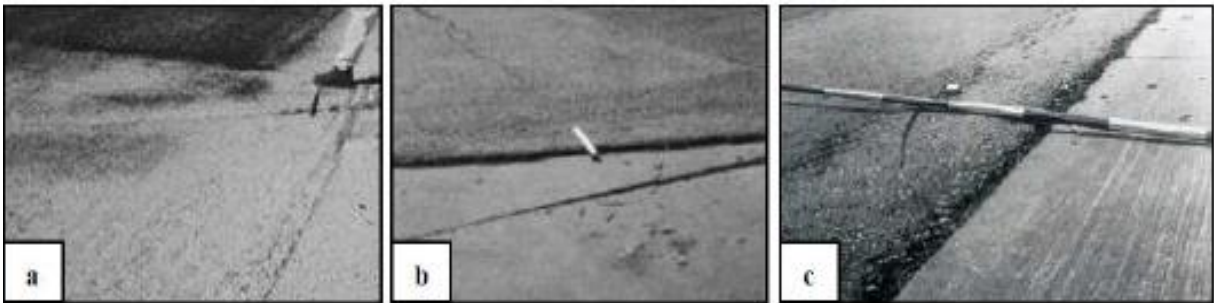
Figura 18: Desplazamiento De Nivel De Severidad Bajo (a), Medio (b) y Alto (c). (Fuente: Rodríguez, 2009).
