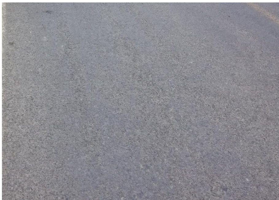
Figura 90: Unidad De Muestra - 43. Corrugación De Severidad Baja.
