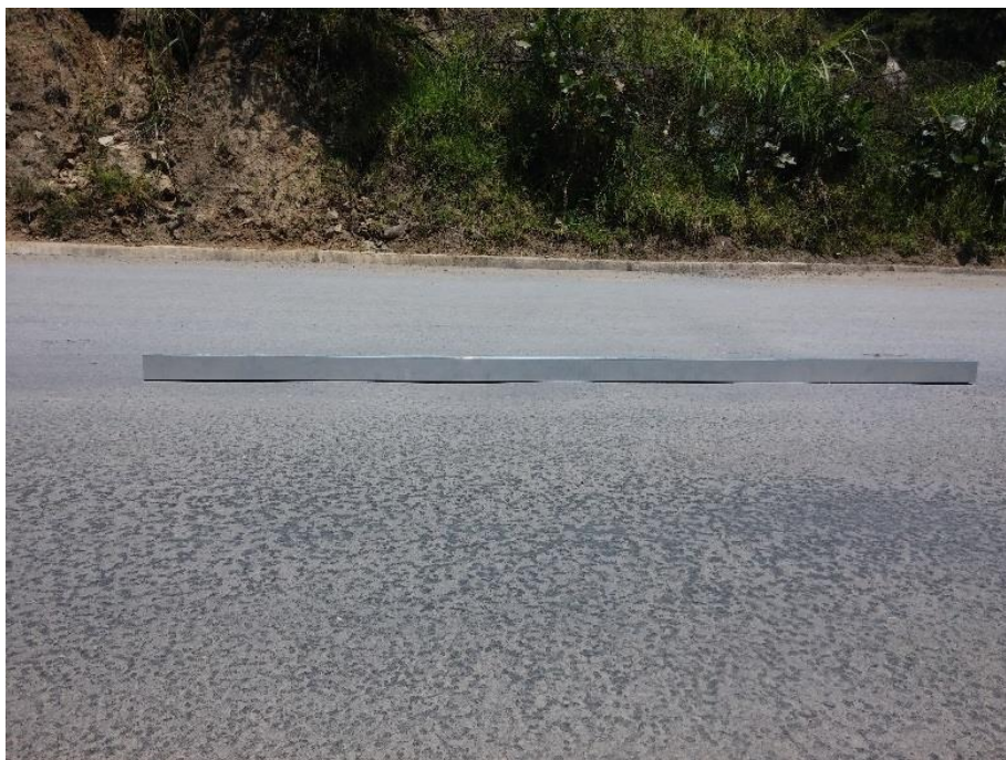
Figura 58: Unidad De Muestra - 11. Corrugación De Severidad Baja.
