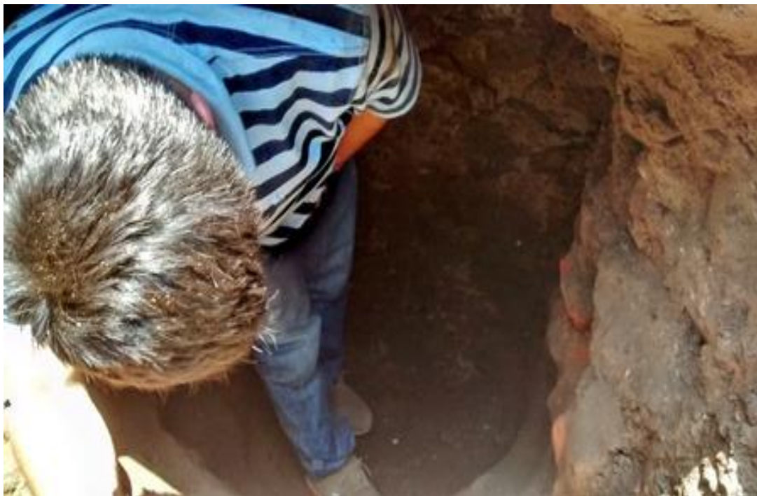
Foto 4: Excavación de la calicata a 1.20 m
