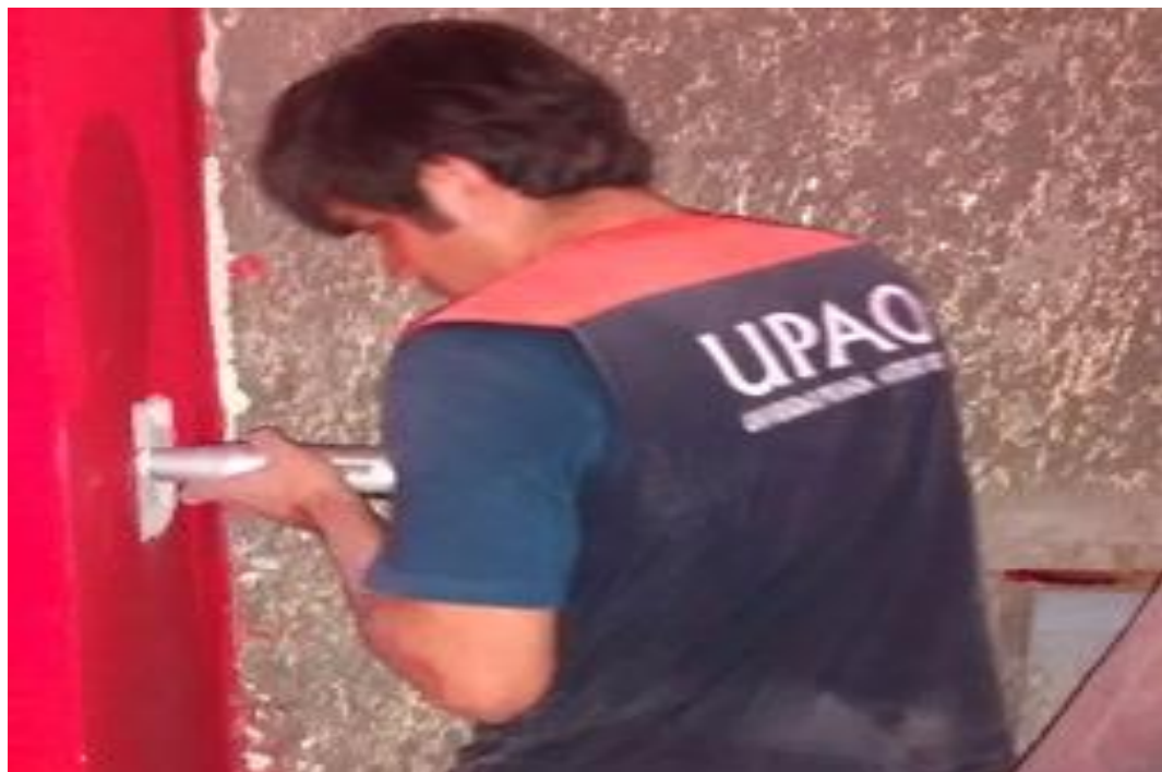
Foto 14: Evaluando la uniformidad del concreto in situ, en la columna.
