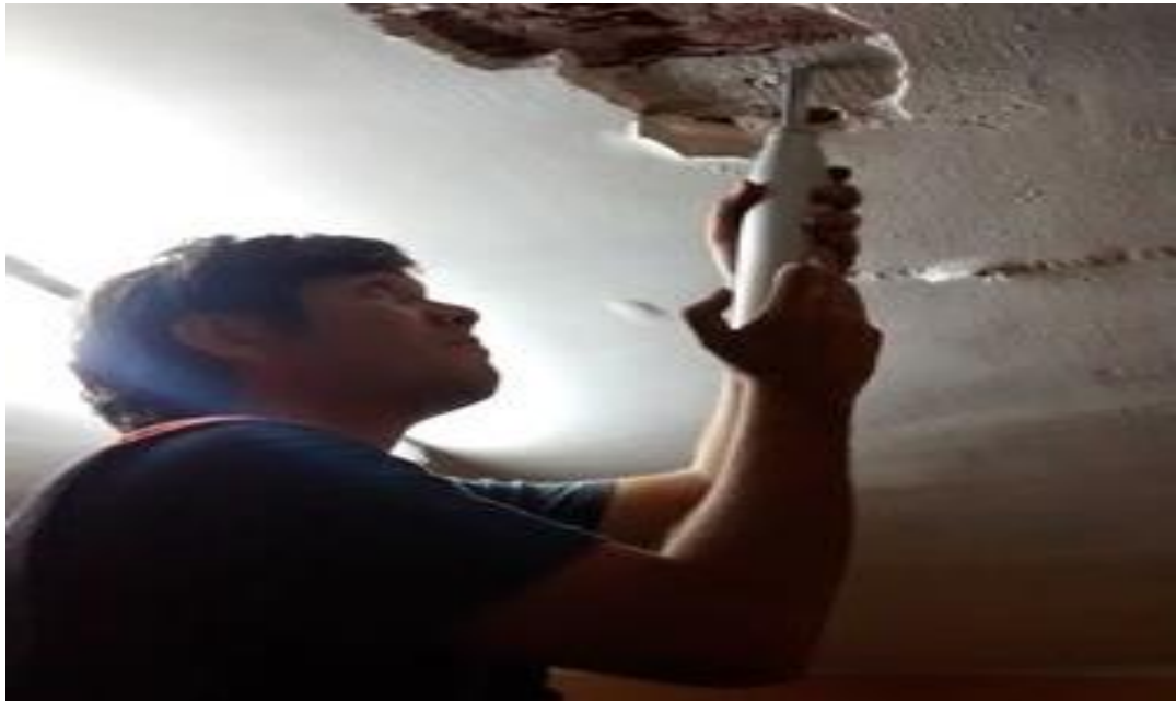
Foto 13: Evaluando la uniformidad del concreto in situ, en la vigüeta.
