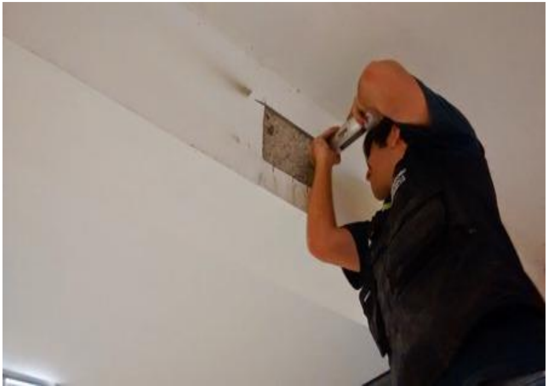
Foto 9: Evaluando la uniformidad del concreto in situ.
