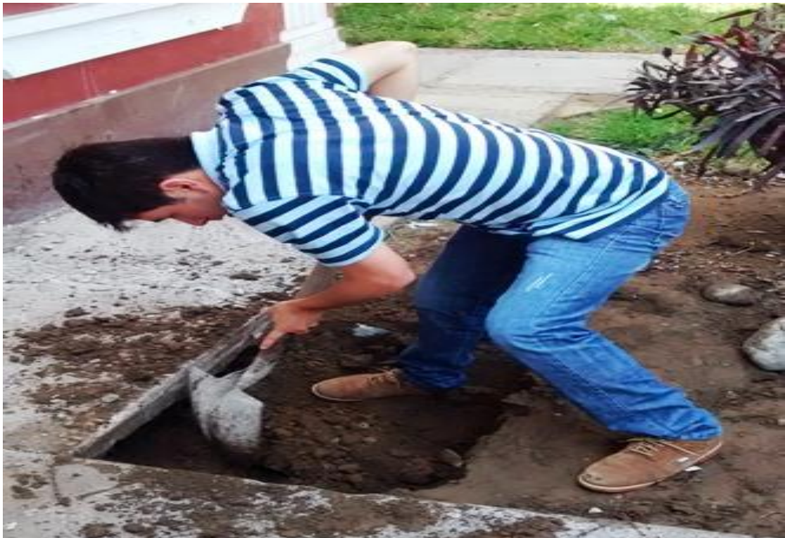
Foto 2: Excavación de la calicata 1.
