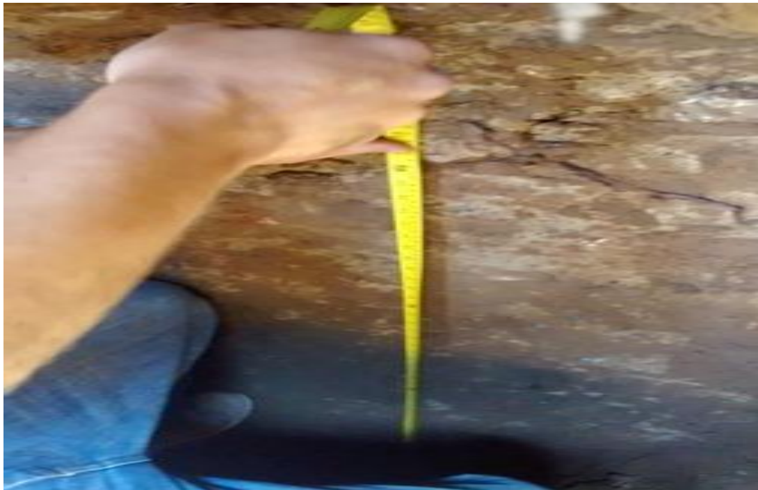
Foto 5: Comprobación de la altura del cimiento.
