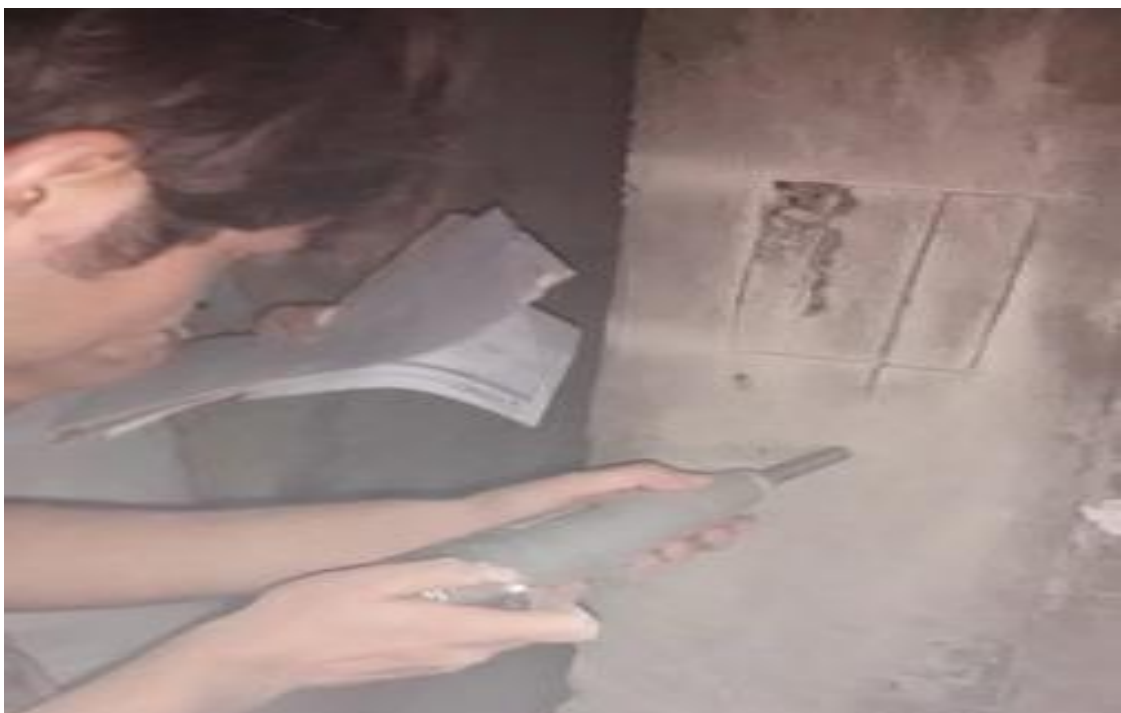
Foto 12: Evaluando la uniformidad del concreto in situ, en la columna.
