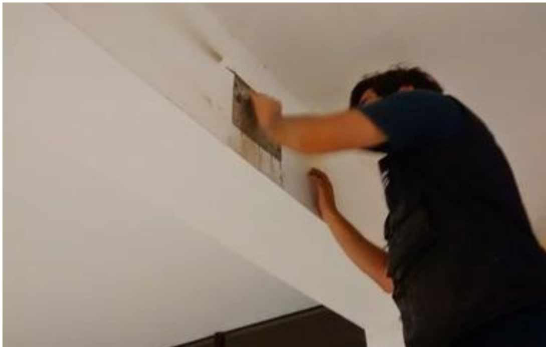
Foto 8: Lijado de la viga, para retirar todo el recubrimiento existente.
