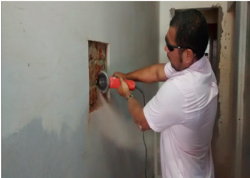
Foto 15: Perforación en muro existente de albañilería con espesor, e=0.25m .
