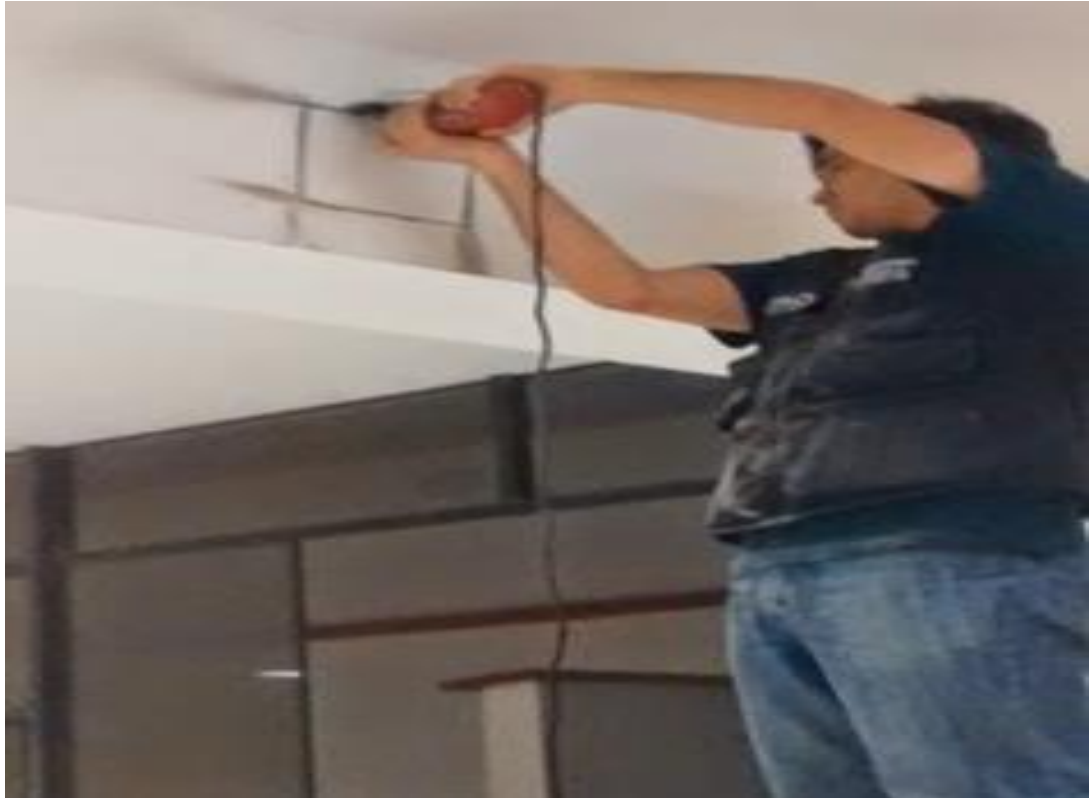
Foto 7: Retiro del recubrimiento en viga, para su respectiva prueba.
