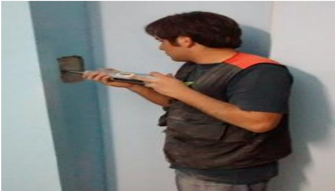
Foto 11: Evaluando la uniformidad del concreto in situ.
