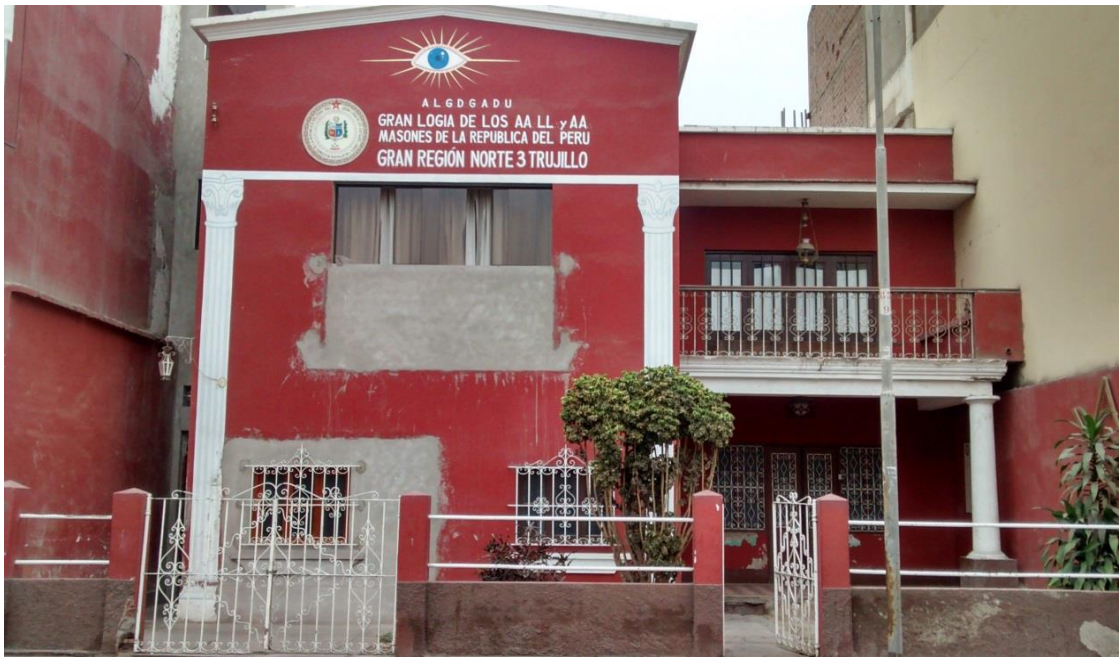
Foto 1: Fachada existente donde se realizó el estudio de suelos.
