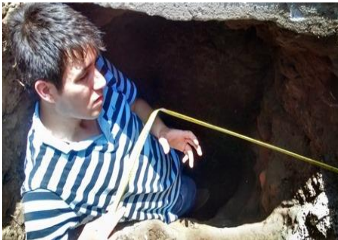
Foto 6: Excavación y comprobación de cimiento de la calicata 1.
