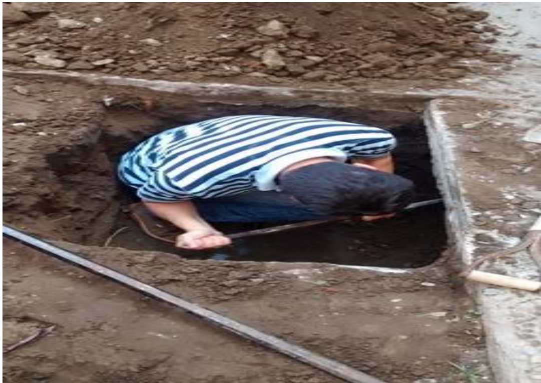
Foto 3: Excavación de la calicata a 0.40 m.
