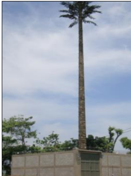
Figura 12. Torre Monopolo mimetizado o camuflado tipo palmera – Greenfield. Fuente propia.
