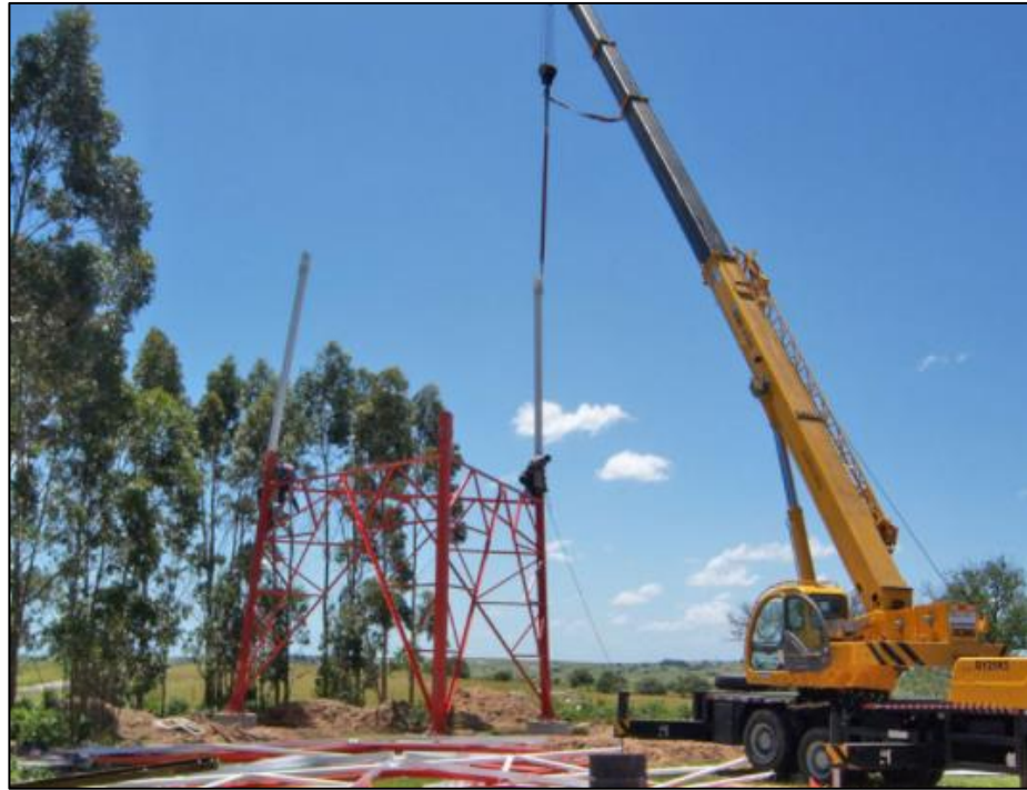
Figura 30. Izaje de Cuerpos de Torre Autosoportada. Fuente propia.
