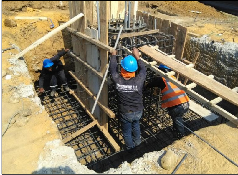
Figura 22. Construcción de Cimentación de Torre Monopolo. Fuente propia.
