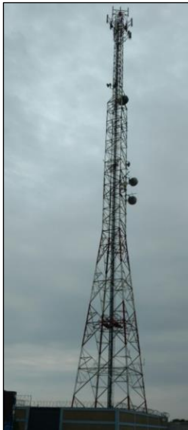
Figura 15. Torre Autoportada – Sección Cuadrada – Greenfield. Fuente propia.
