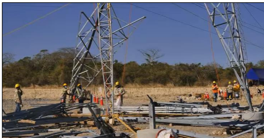
Figura 29. Izaje de Montante de Cuerpo de Torre Autosoportada. Fuente propia.
