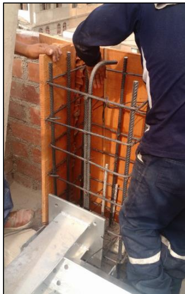
Figura 18. Construcción de Pedestal para Torre Arriostrada. Fuente propia.
