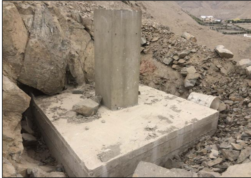
Figura 20. Construcción de Cimentación para Torre Ventada. Fuente propia.
