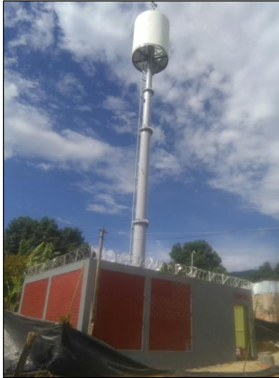
Figura 11. Torre Monopolo con mimetizado tipo radomo - Greenfield. Fuente propia.
