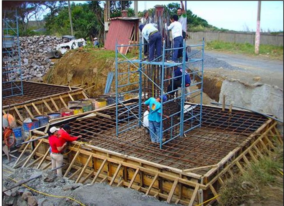
Figura 24. Construcción de Cimentación de Torre Autosoportada. Fuente propia.
