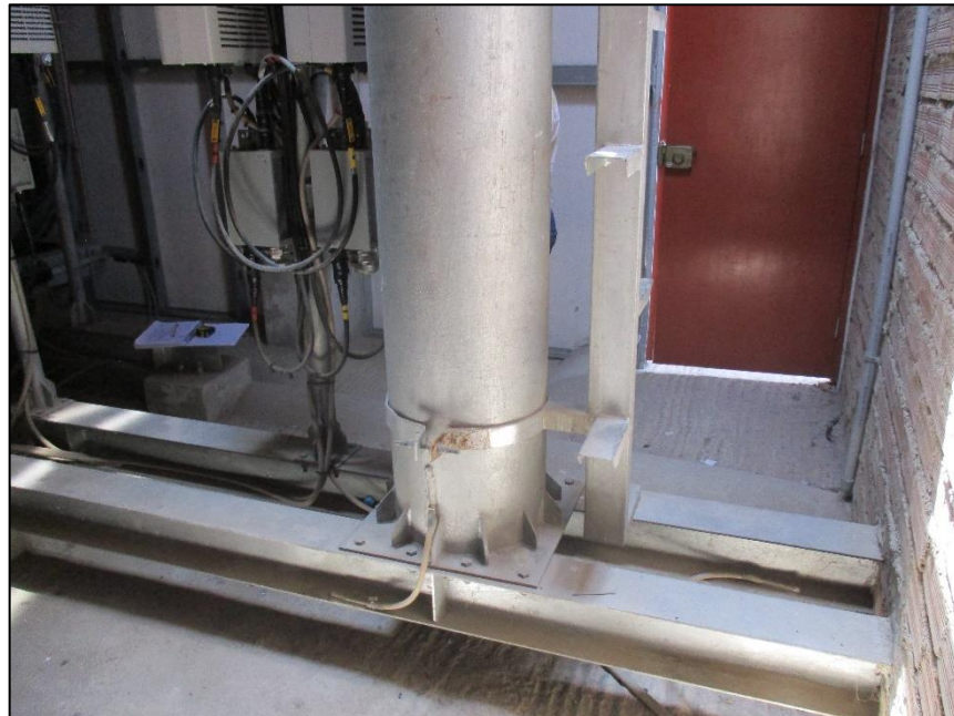
Figura 26. Vigas H para repartir cargas de Torre Monopolo. Fuente propia.
