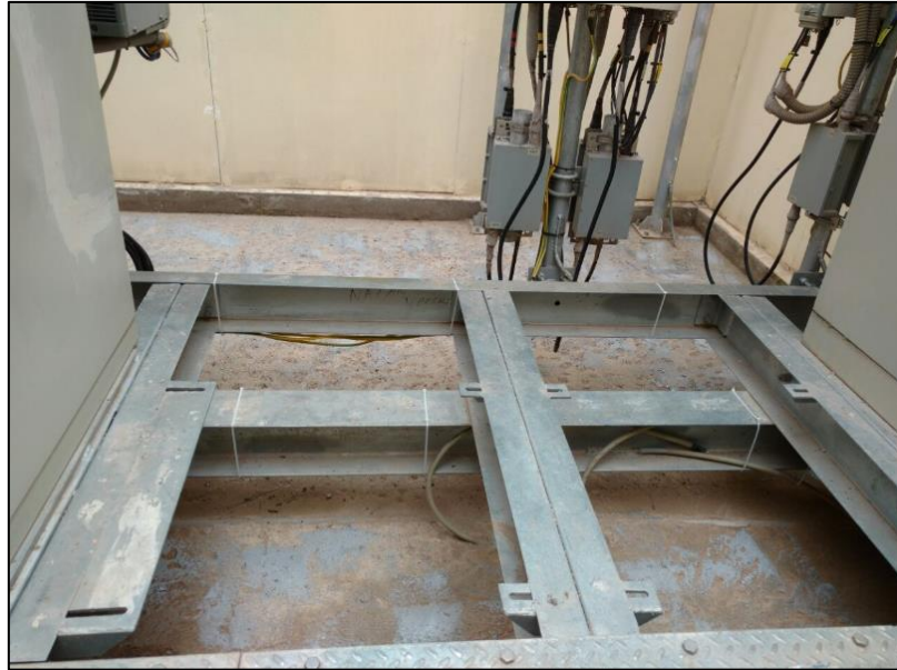
Figura 25. Instalación de Vigas H para repartir cargas de Estación. Fuente propia.
