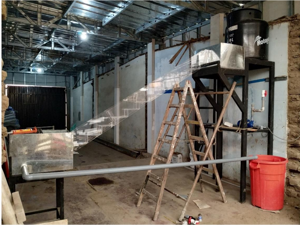
Ilustración 12. Montaje del prototipo. Fuente: Elaboración Propia
