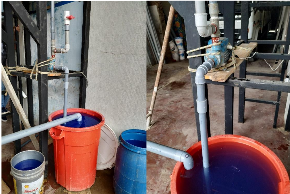
Ilustración 14. Montaje del sistema de reciclaje de agua. Fuente: Elaboración Propia
