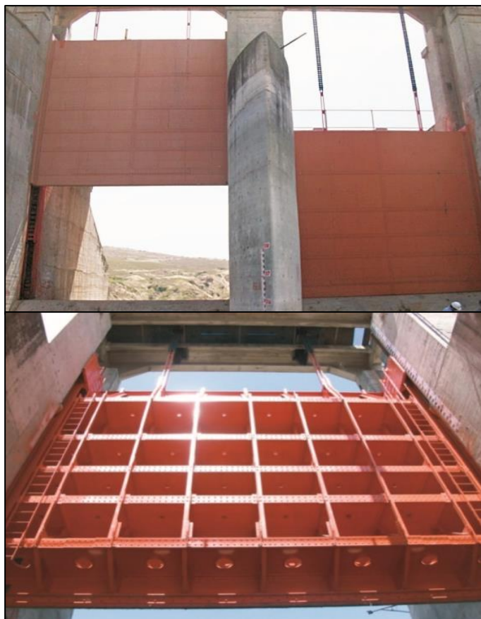
Figura 4. Compuerta deslizante de la presa Abelardo L. Rodríguez, Baja California, México
