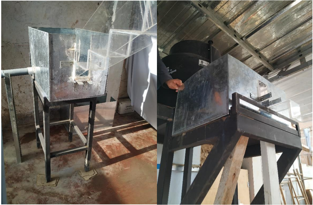
Ilustración 16. Poza disipadora y tanque de almacenamiento terminados. Fuente: Elaboración Propia
