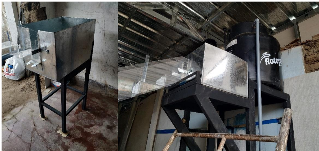
Ilustración 13. Montaje de poza disipadora y tanque de almacenamiento. Fuente: Elaboración Propia
