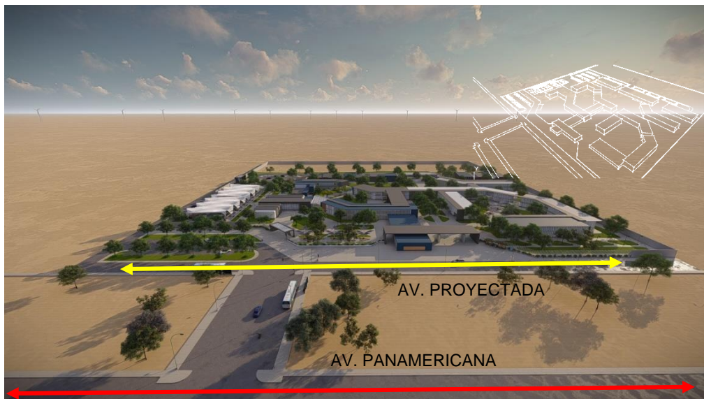
Imagen 34: Vías principales para acceder a la infraestructura.
