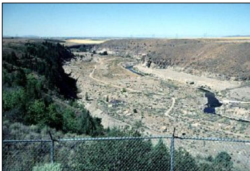
Figura 1.9. Residuos de material (Grava) de la Presa Teton.
