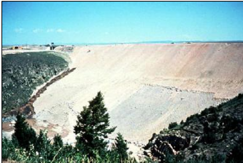
Figura 1.6. Indicios de la rotura.
