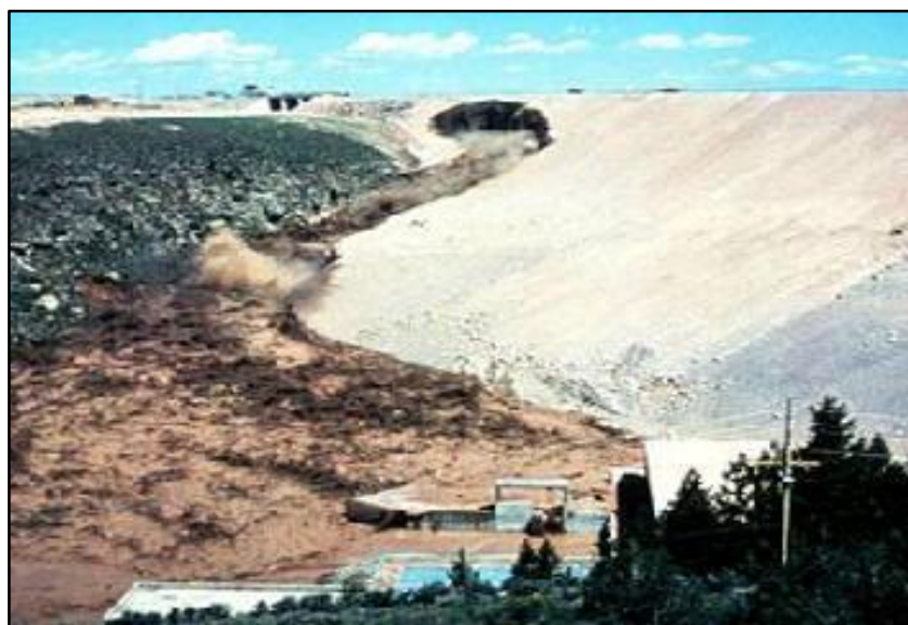
Figura 1.7. Rotura por pipping (tubificación).
