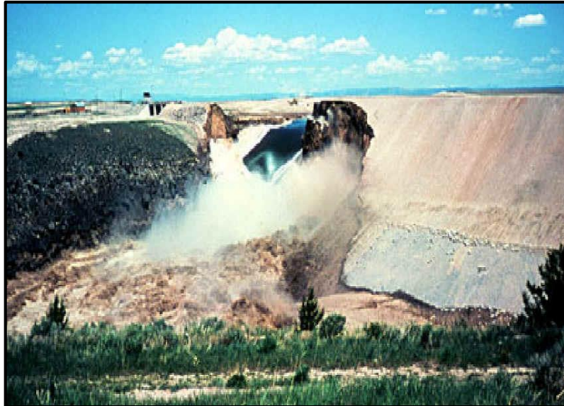
Figura 1.8. Formación casi total de la brecha.
