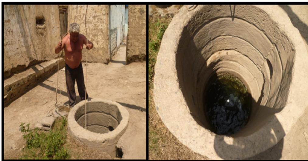
**Fotografía 1: Abastecimiento de Agua Potable mediante Pozo Subterráneo**
