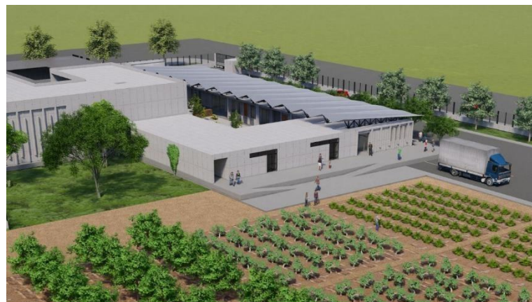
FIGURA 21: Techo a Doble Cubierta – Sector C
