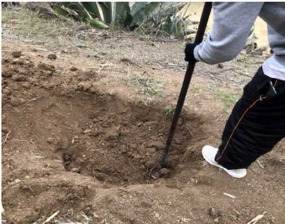
Foto N° 10: Excavación de calicatas
