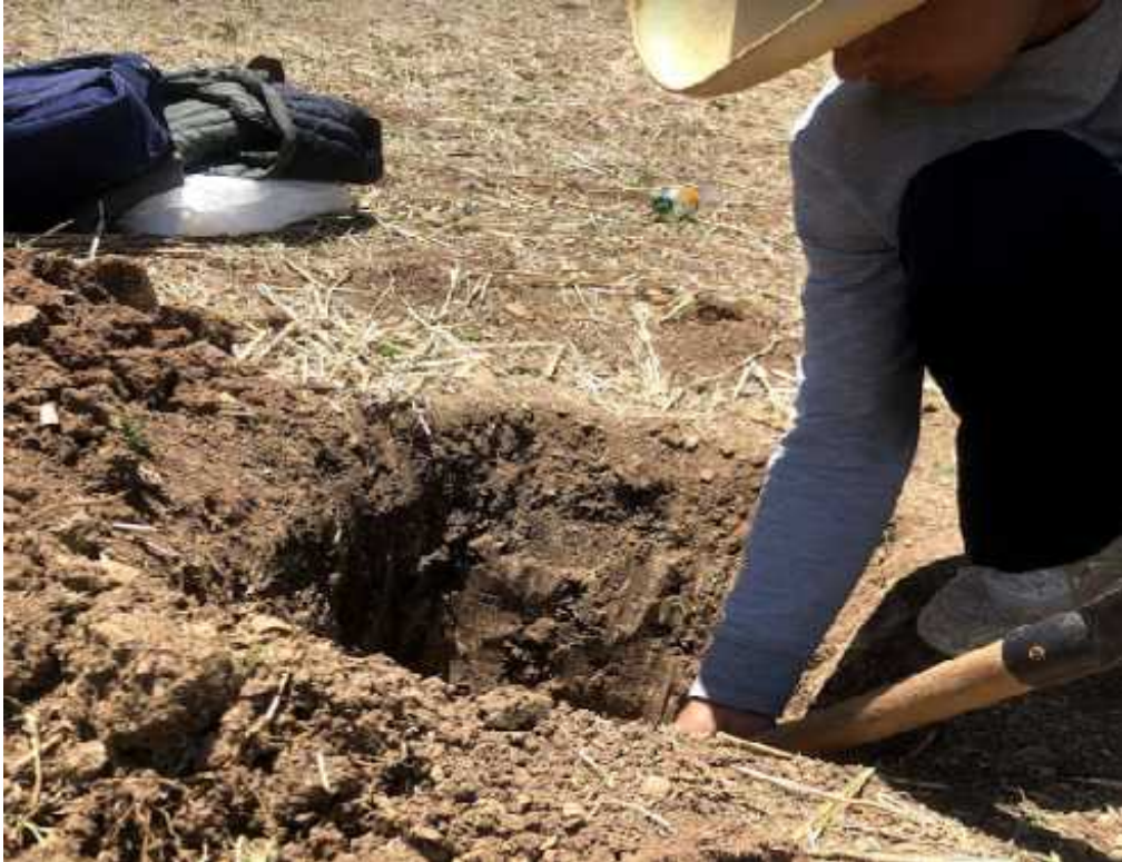
Foto N° 11: Excavación de calicatas
