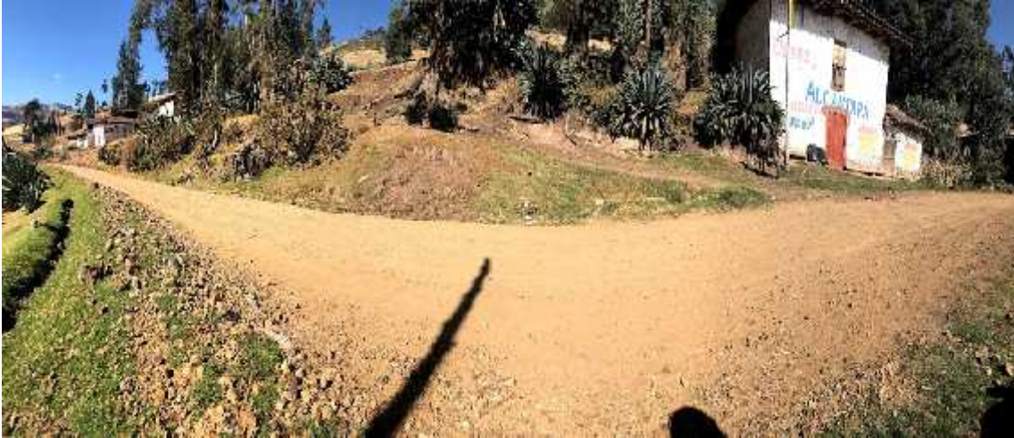
Foto N° 1: Carretera Cunguay - Santiago de Chuco. Punto de inicio de la vía proyectada
