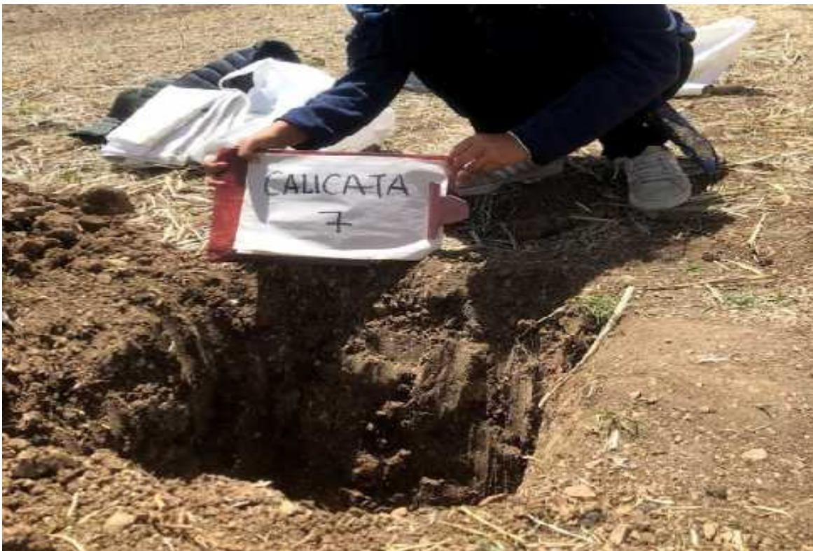
Foto N° 18: Calicata 7 (C-7), profundidad 1.50m.
