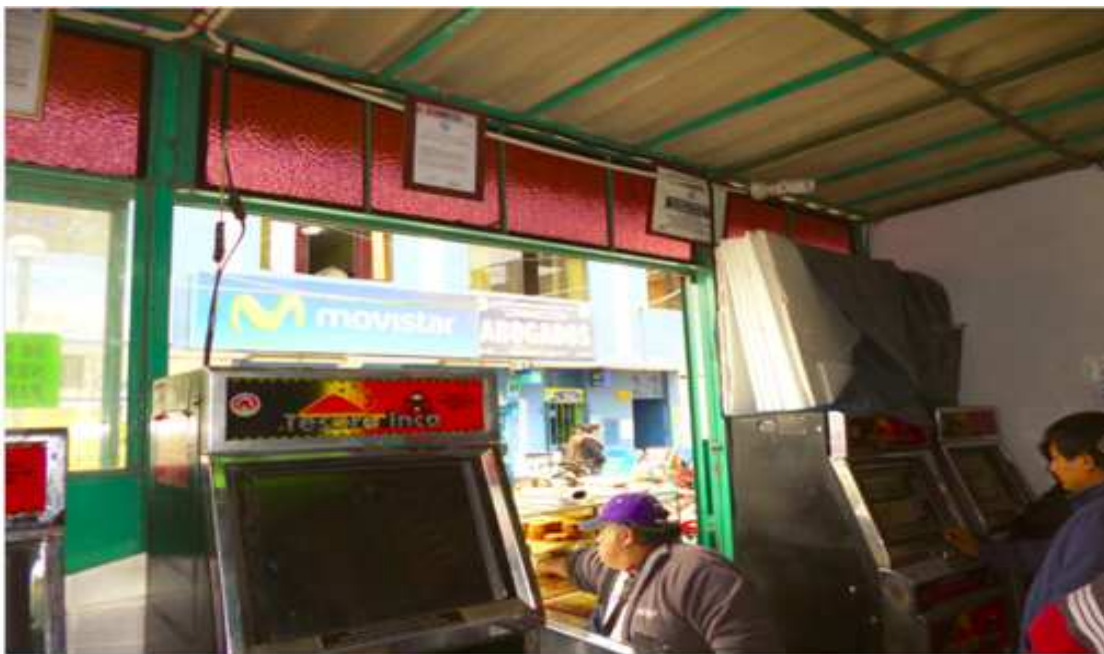
Figura 3.16: Cableado de Instalacion de terminales VLT
