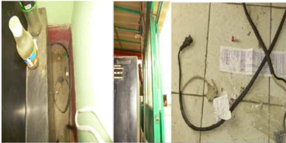
Figura 3.14: Instalación de cable data Power 12v
