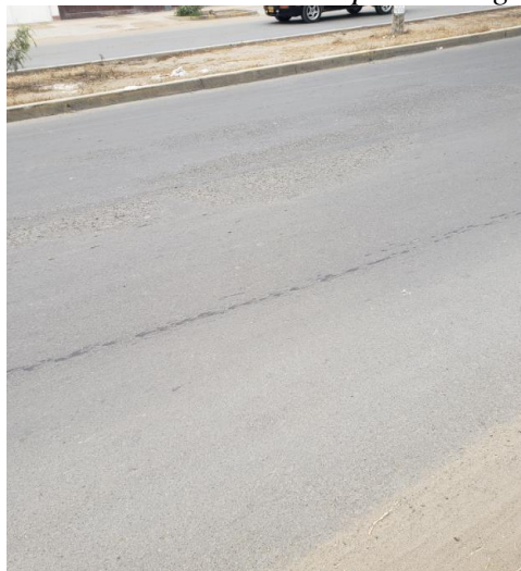
Ilustración 27 - Perdida de película ligante
