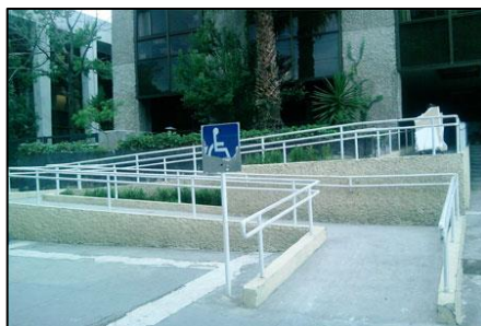
Ilustración 49: Rampa de acceso para discapacitados.
