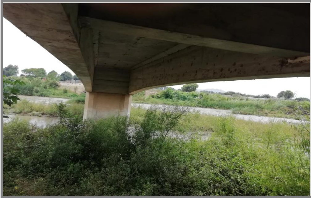
Imagen 22 – Sub estructura del puente – Perspectiva. Fuente: Autoría propia
