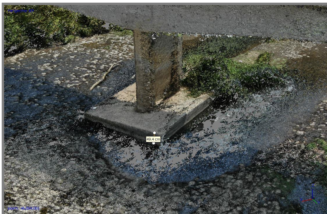
Imagen 41 – Vista en perspectiva del levantamiento – “Puente Huacas” Fuente: Autoría propia
