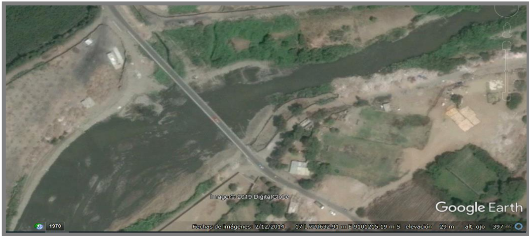
Imagen 13 – Vista en planta – Puente Huacas – Imagen satelital 12/02/14. Fuente: Google Earth
