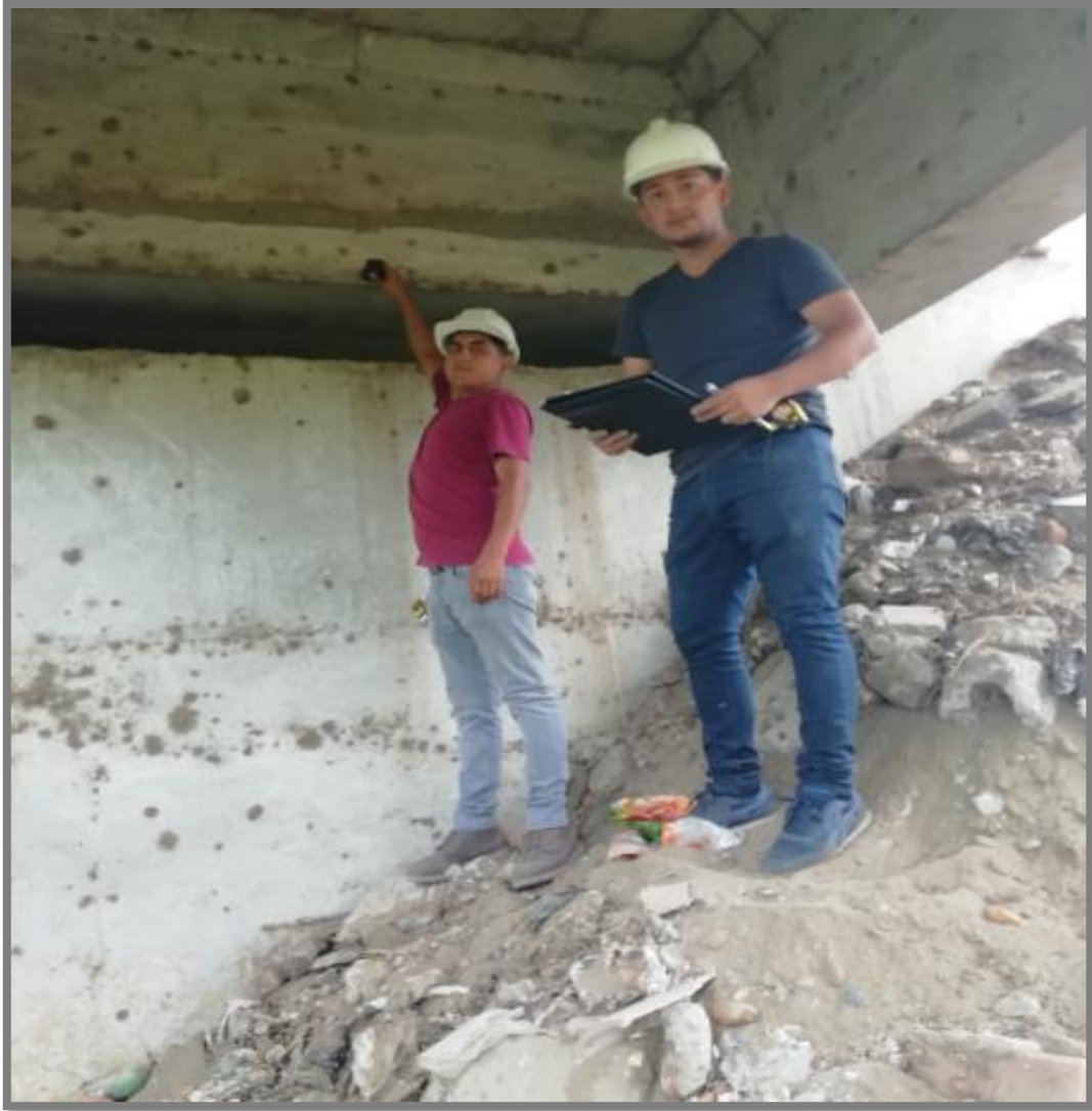
Imagen 21 – Sub estructura del puente – Toma de medidas. Fuente: Autoría propia
