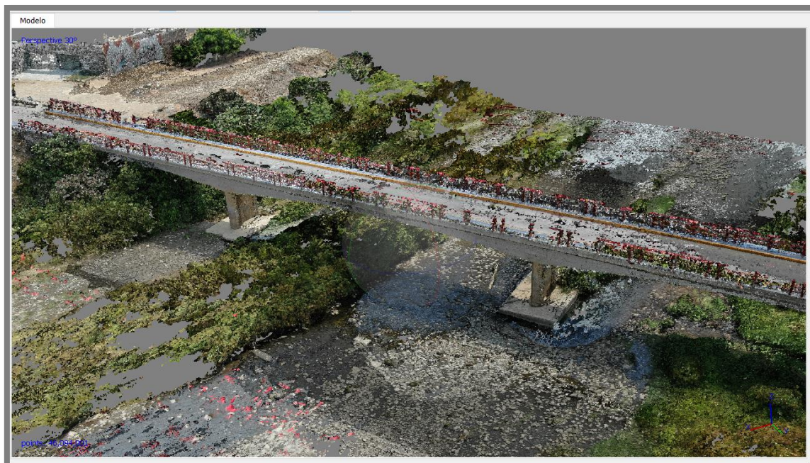
Imagen 40 – Vista en perspectiva del levantamiento – “Puente Huacas” Fuente: Autoría propia
