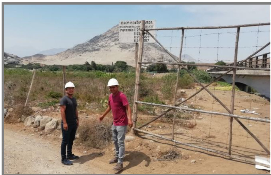
Imagen 23 – Margen derecha del Puente Huacas. Fuente: Autoría propia
