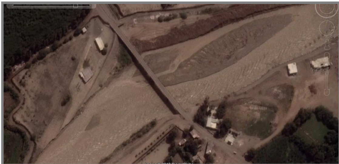
Imagen 15 – Vista en planta – Puente Huacas – Imagen satelital 31/03/17. Fuente: Google Earth
