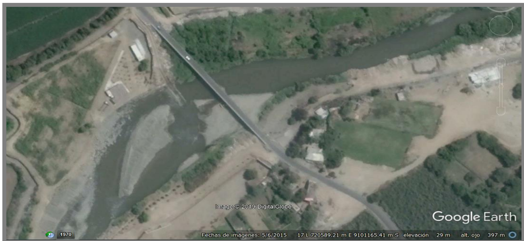
Imagen 14 – Vista en planta – Puente Huacas – Imagen satelital 06/05/15. Fuente: Google Earth
