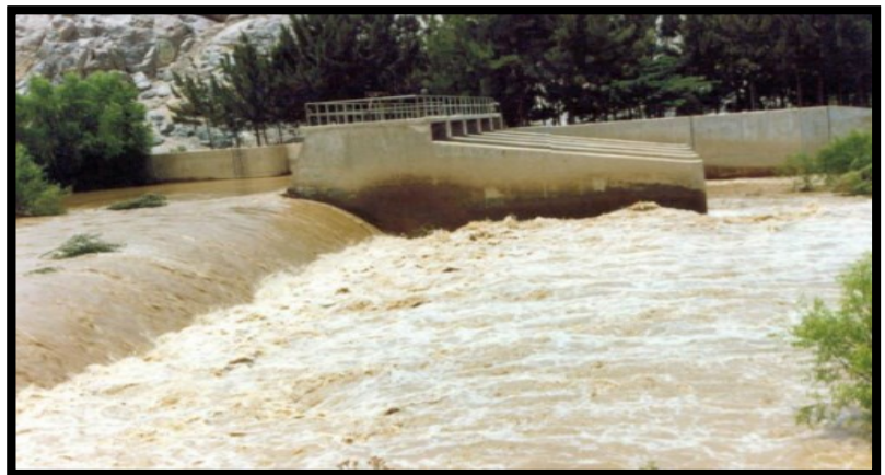
Figura 3: Barraje mixto es empleado en bocatomas y compuertas.
