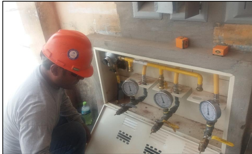
Figura 43, fuente: Técnico instalador
