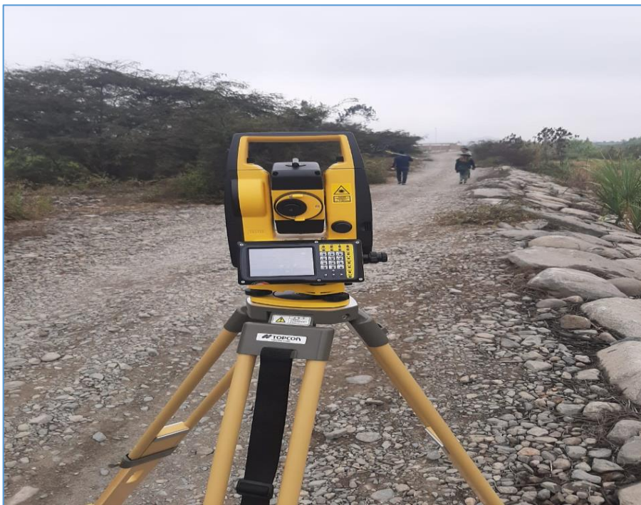
Figura N° 76: lectura de los puntos de topografía
