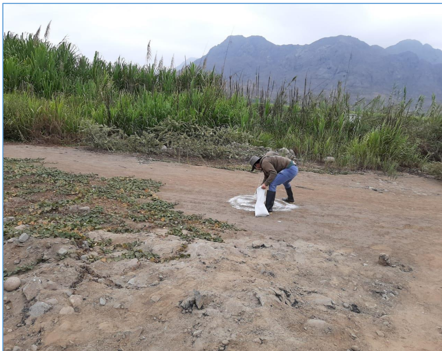
Figura N° 74: colocación de los puntos de control en ambos márgenes del río Chicama cada 500 m
