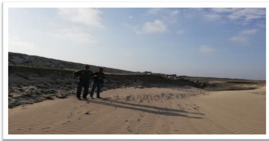
Figura N° 1: Socavación en el cauce
