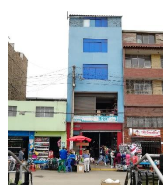
Figura N° 46: Fachadas de Edificaciones Jr. Sinchi Roca
