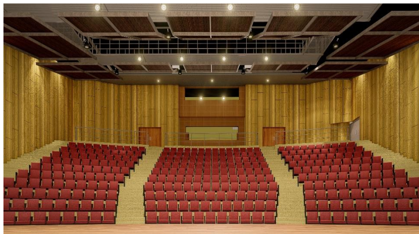
Figura Nº 63: Equipos de Iluminación, Pared y Plafones Acústicos
