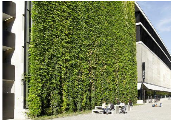
Figura Nº 35: Muros Verdes en Edificio
