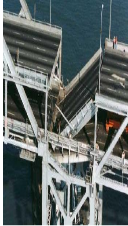
Imagen 7: Colapso de puentes debido a longitud de soporte insuficiente. Nigata 1964; San Fernando 1971; San Francisco 1989; Chile 2010.
