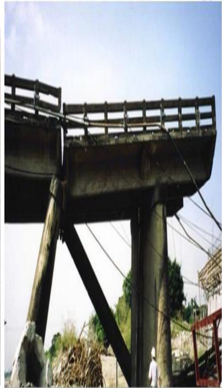
Imagen 10: Daño estructural debido a la falla de suelo. Loma Prieta 1989; Taiwán 1991; Chile 2010.
