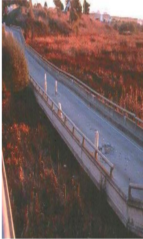
Imagen 10: Daño estructural debido a la falla de suelo. Loma Prieta 1989; Taiwán 1991; Chile 2010.
