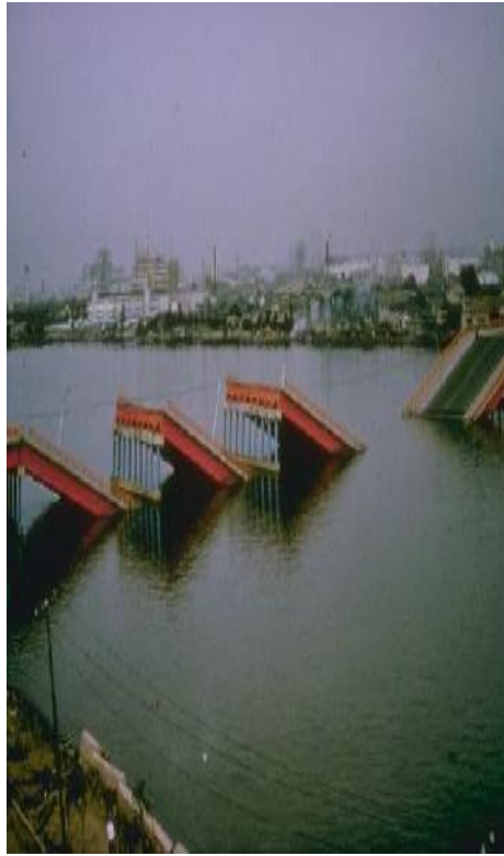
Imagen 7: Colapso de puentes debido a longitud de soporte insuficiente. Nigata 1964; San Fernando 1971; San Francisco 1989; Chile 2010.
