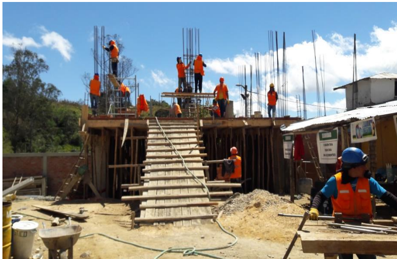
Fotografía N° 4. Colocación de estribos en columnas.
