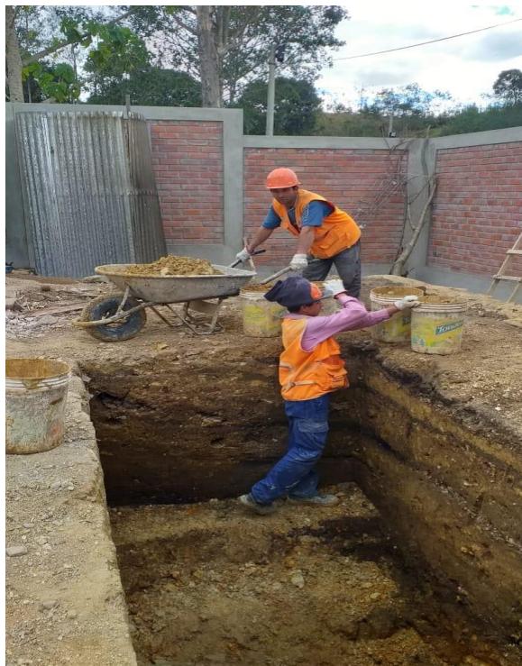
Fotografía N° 1. Excavación de zapatas
