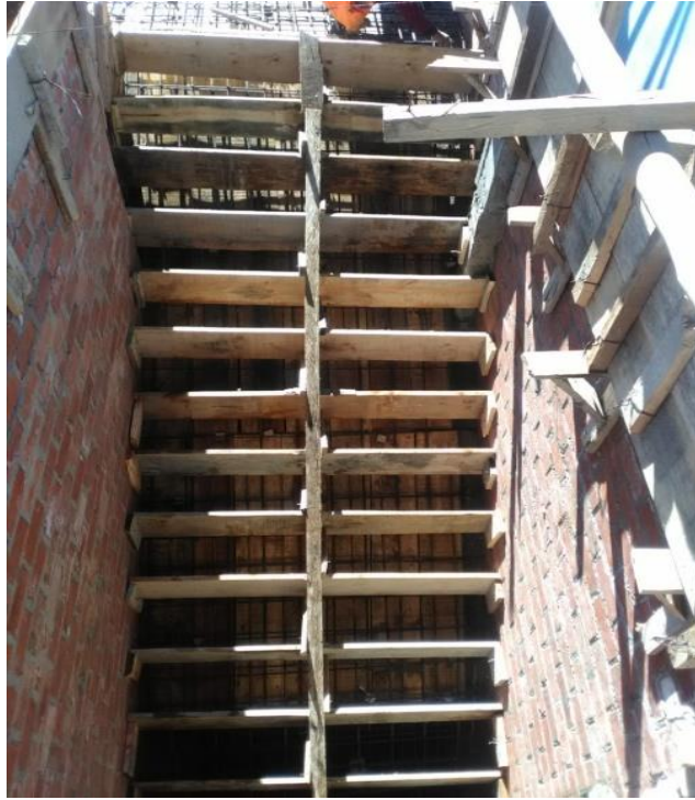
Fotografía N° 3. Encofrado de escalera.
