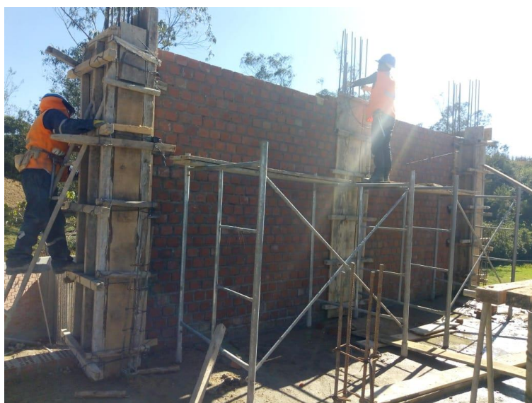
Fotografía N° 2. Encofrado de columnas.
