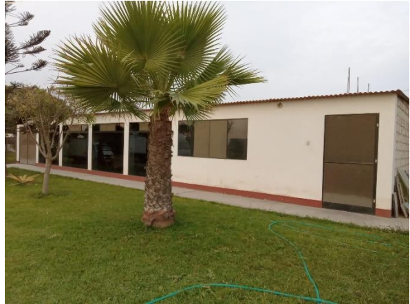
Planta de agua ubicada en el Ovalo de Huanchaco.
