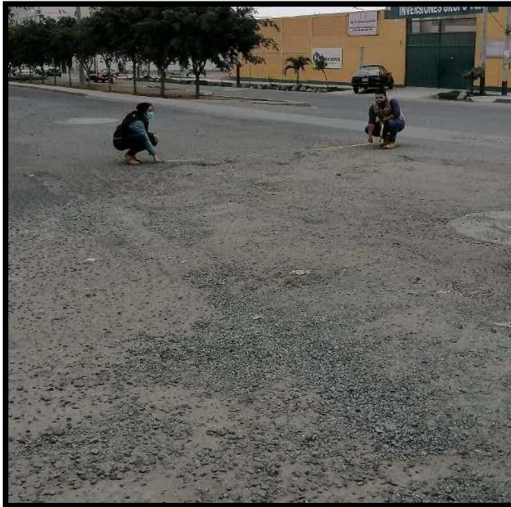
Foto n°3: De IDA de la Av. Mansiche hasta la Av. Micaela Bastidas –Falla n°19 (Desprendimiento de Agregado)
