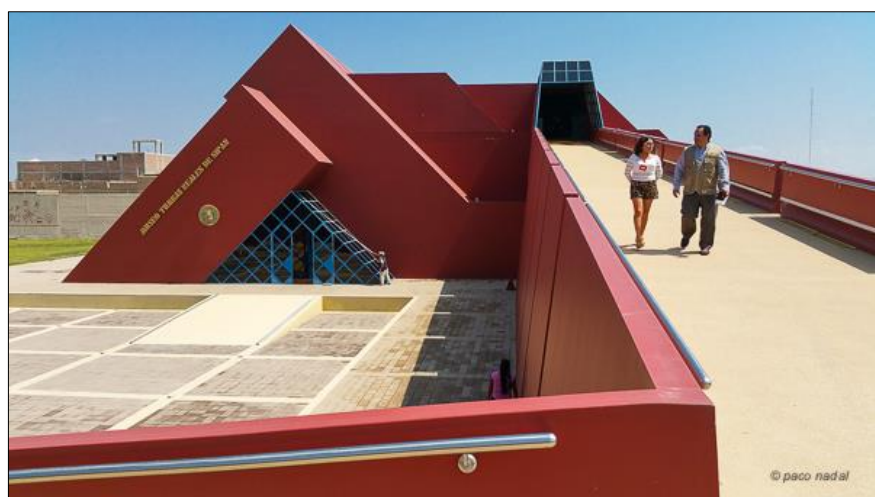
FIGURA Nº 120: RAMPA DE ACCESO AL TERCER PISO
