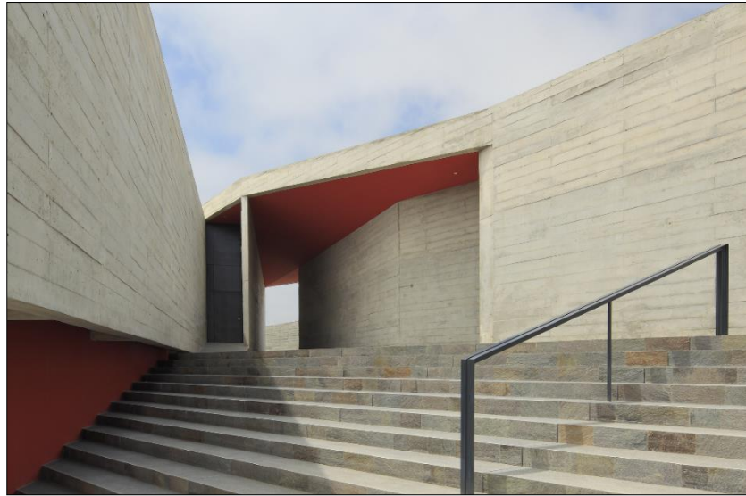
FIGURA Nº 166: ESPACIOS ENTRE MÓDULOS PARA FLUIDEZ DEL AIRE FUENTE: https://www.canalipe.tv/noticias/identidad/10
