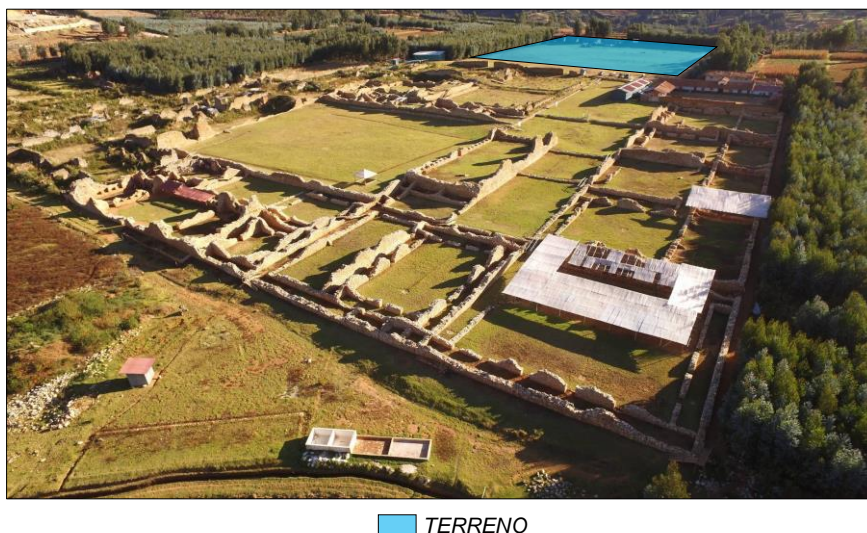
FIGURA Nº 38: UBICACIÓN DEL TERRENO EN WIRAQOCHAPAMPA FUENTE: Unidad Ejecutora 007 – Marcahuamachuco
