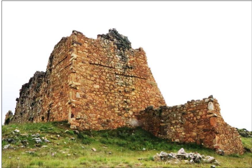
FIGURA N° 03: EDIFICIO DE MARCAHUAMACHUCO – GALERÍA A
