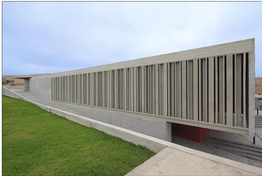
FIGURA Nº 163: BRISOLEI DE CONCRETO FUENTE: https://www.canalipe.tv/noticias/identidad/10
