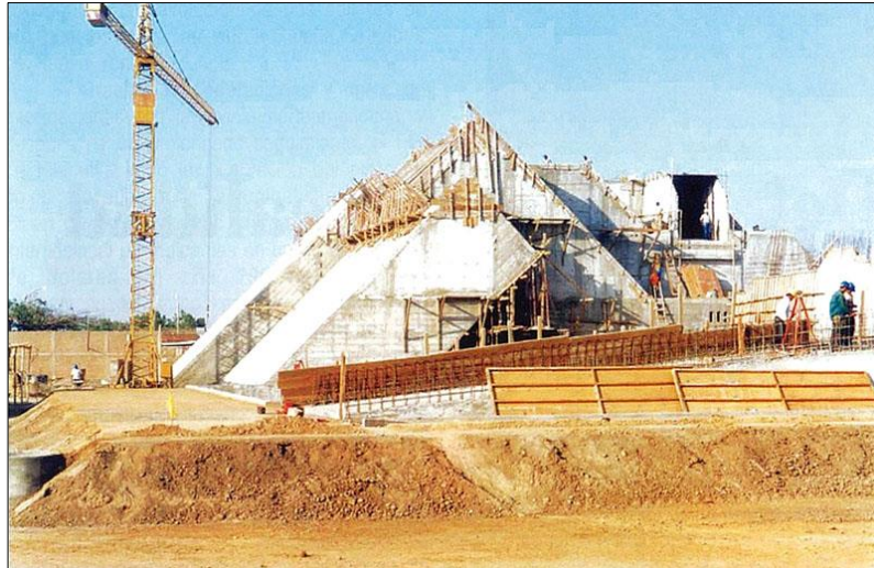
FIGURA Nº 129: CONSTRUCCIÓN DEL MUSEO
