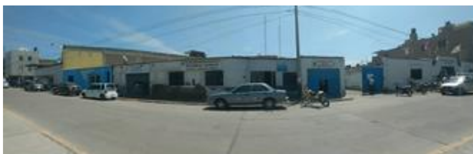
Figura N° 19: Deficiente Infraestructura Física del frontis de la M.D.L.V.
