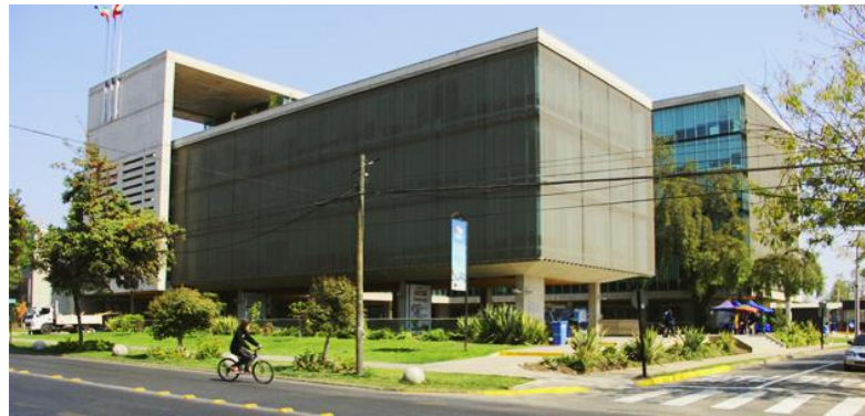
Figura N°11: Municipalidad de Recoleta – Chile Fuente: www.archdaily.pe
