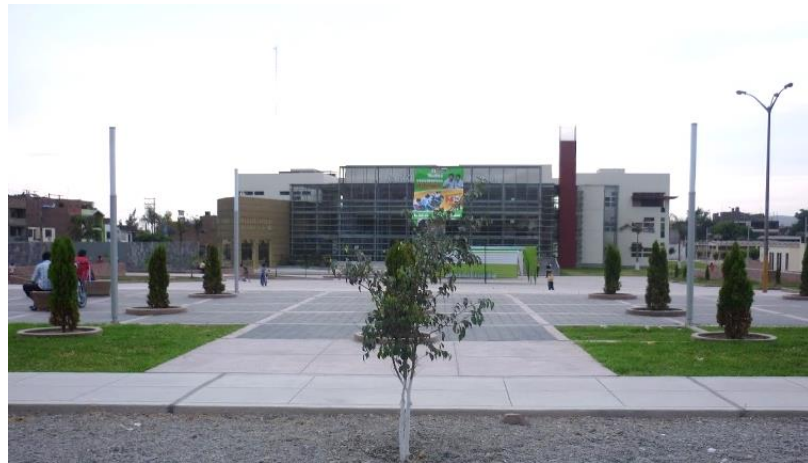
Figura N°10: Municipalidad Distrital de Comas – Lima. Fuente: Municipalidad Distrital de Comas
