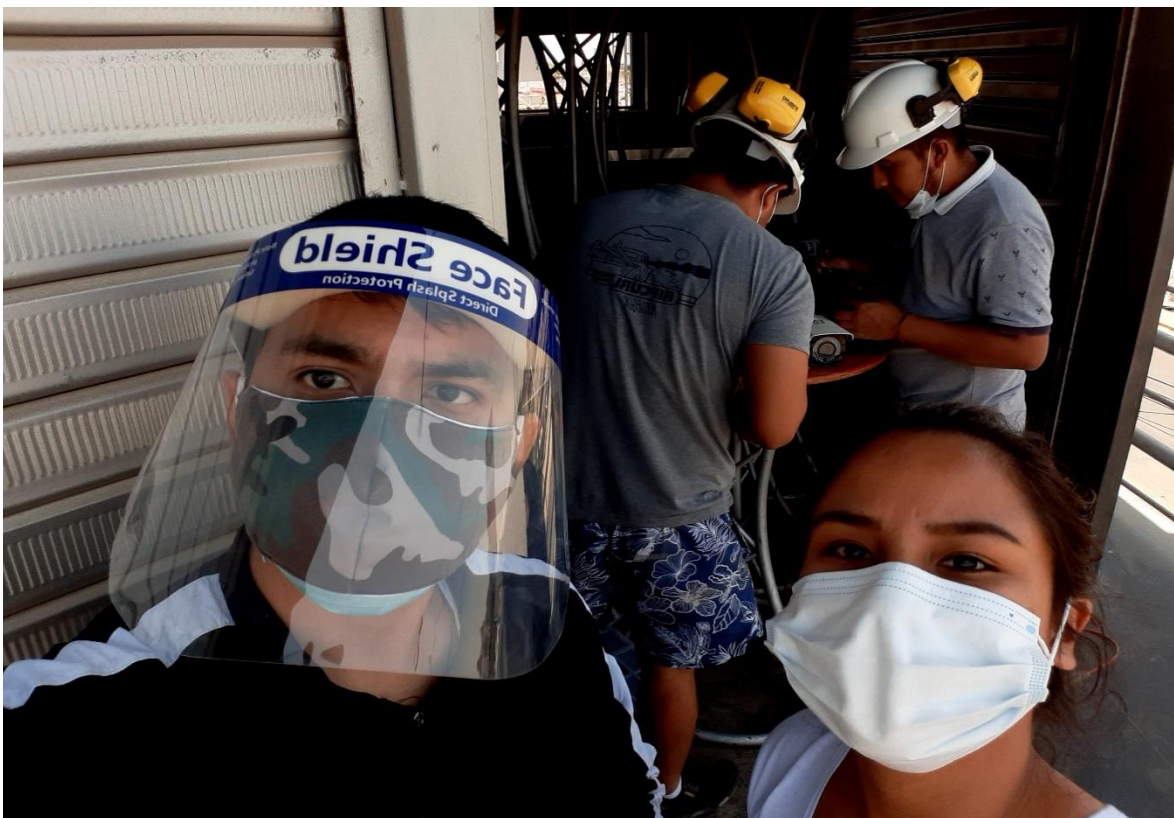
Foto N° 06: Instalación de cámaras por personal técnico especializado
