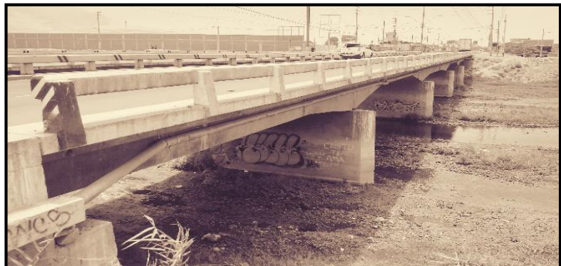
Figura N° 11. Puente Moche en 1990
