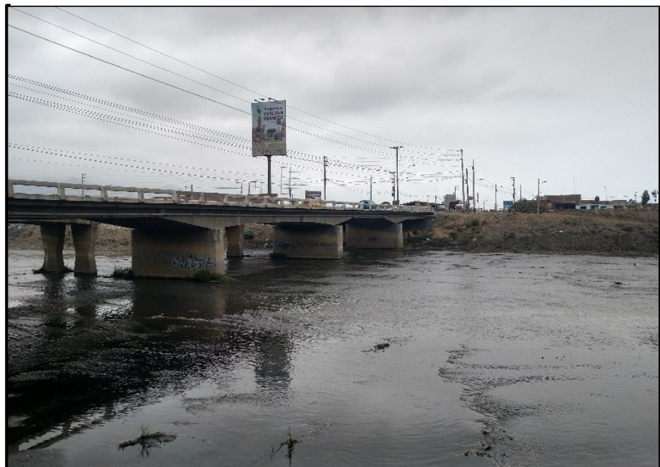
Figura N° 15. Puente Moche en 2019
