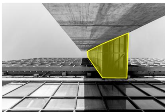
FIGURA N° 50: PUENTE – UNIÓN DE LOS DOS BLOQUES.
