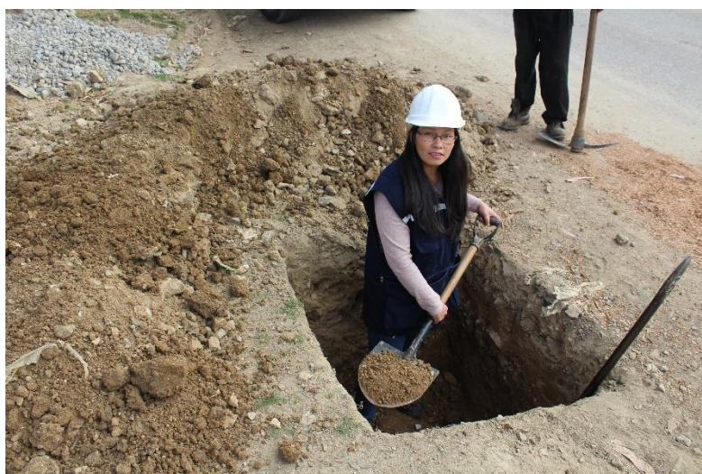
Figura 1.4: Extracción de Material de la Calicata
