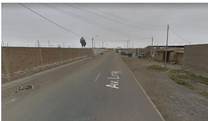
Figura V. Inexistencia de infraestructura de aceras en la Av. La Mar
