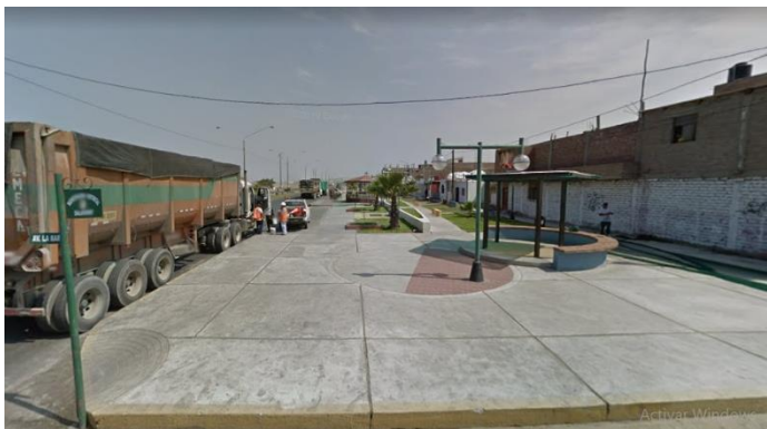
Figura IV. Espacio Público ubicado entre la Av. La Mar y la Av. Principal Salaverry
