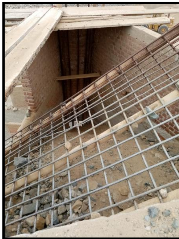
Fotografía N.ª 04: Malla metálica para separar agregado por tamaños.
