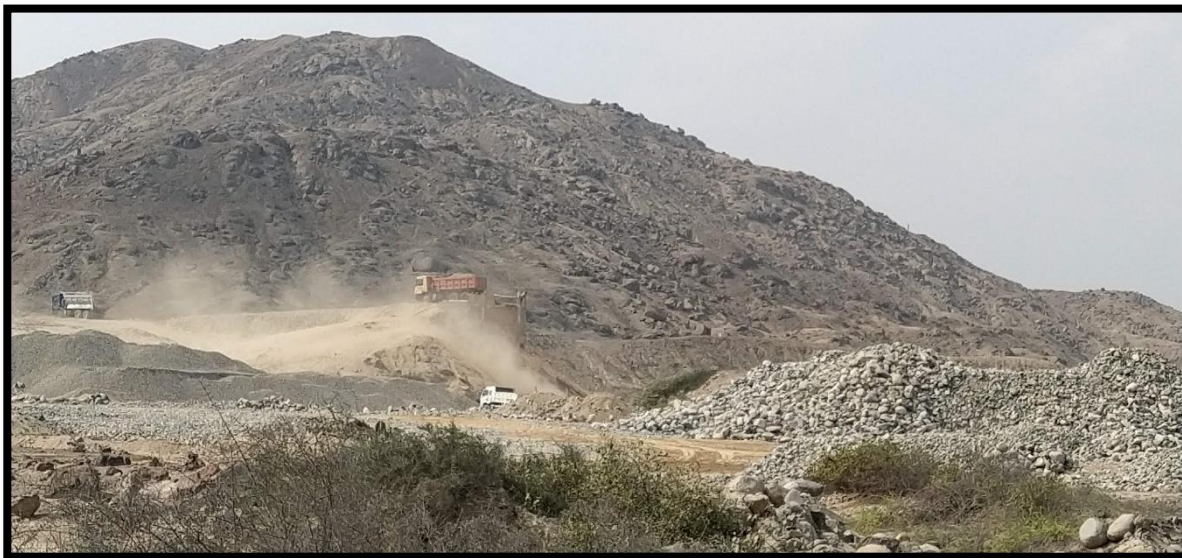
Fotografía N.º 15: Mobilización de material con maquinaria próxima a su tamizado.
