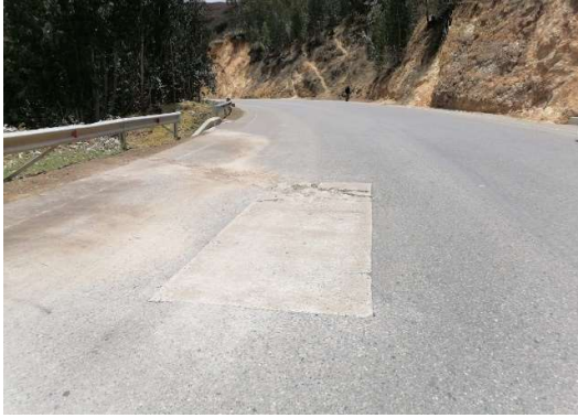
Nota. Km 83+440. Parche con losa de concreto hidráulico, severidad media y alta.
