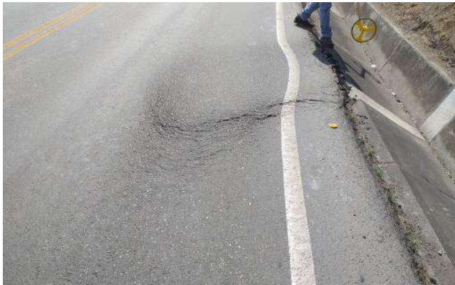
Figura 52 Grieta parabólica severidad alta
