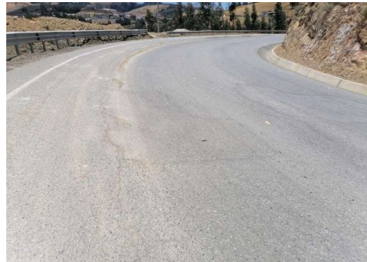
Nota. Km 81+733. Lado izquierdo, parchado de severidad media, ahuellamiento de severidad alta.
