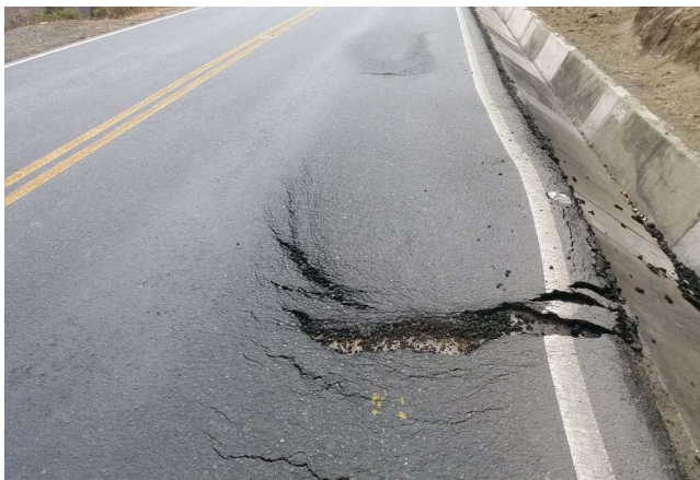
Figura 52 Grieta parabólica severidad alta
