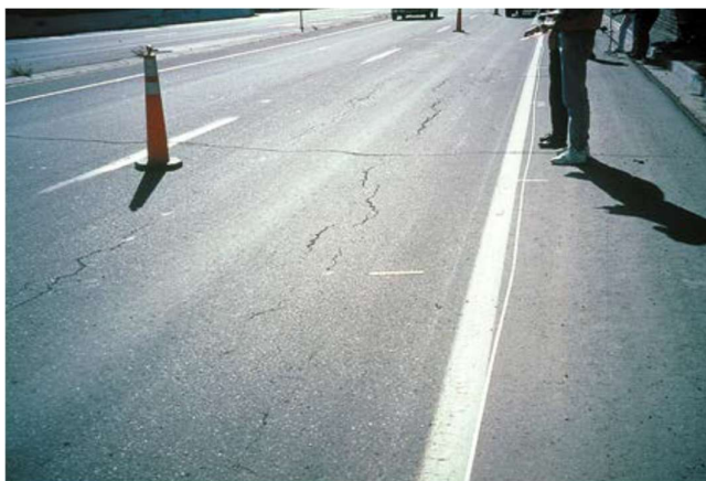
Piel de cocodrilo severidad baja
