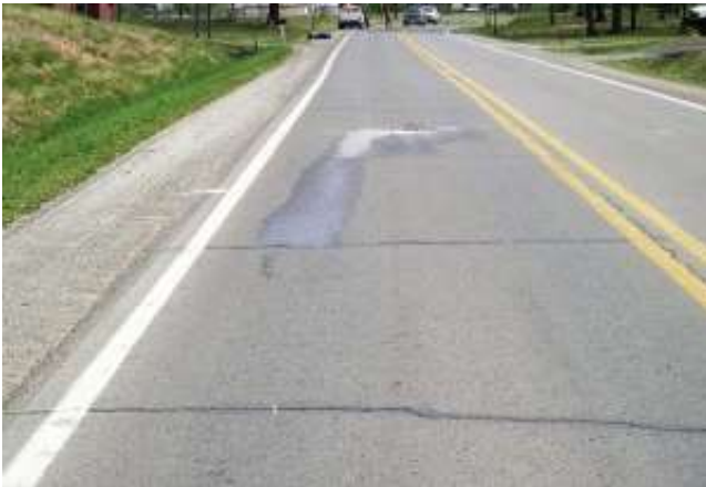
Sellado de fisuras y grietas
