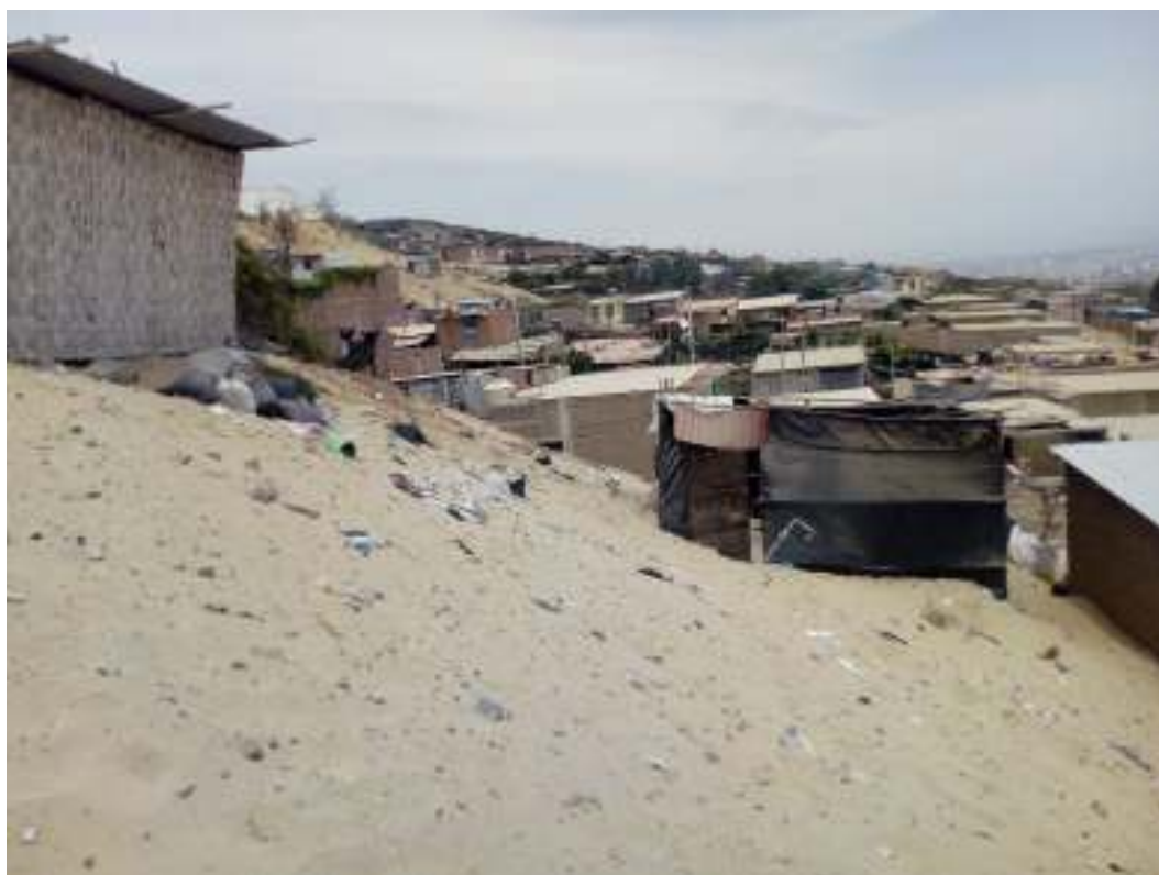
Vista del material precario existentes en las viviendas del AA. HH Richard Acuña y Nuevo Indoamérica.
