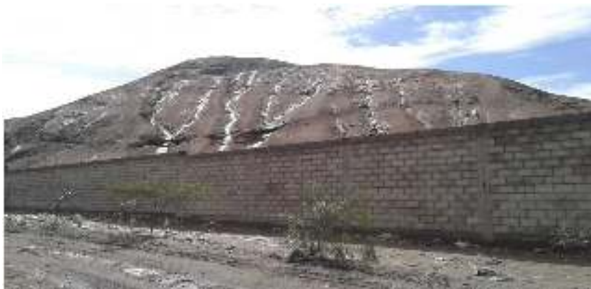
Escurrimiento de lluvias del Cerro Las Cabras
