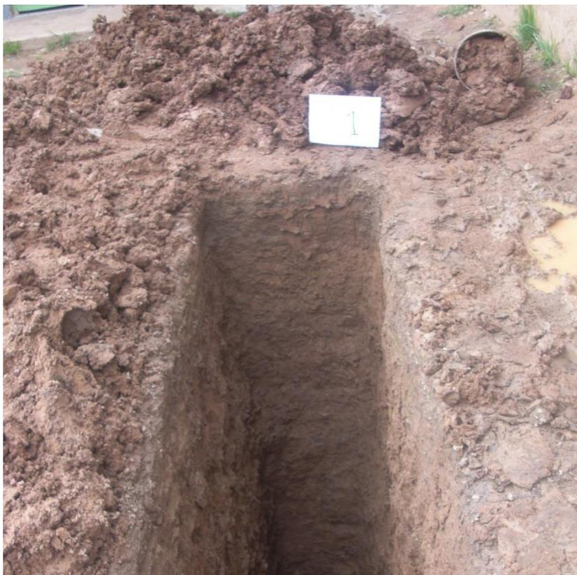
Excavación de calicatas para el estudio de mecánica de suelos
