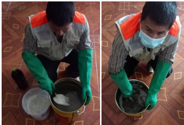
IMAGEN N° 29: Se realizo la mezcla de la cal con el aceite quemado en un recipiente.
