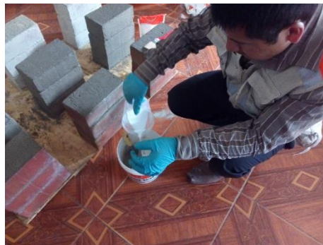
IMAGEN N° 46: Preparación del Impermeabilizante Chema seal.
