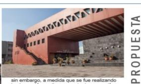
sin embargo, a medida que se fue realizando la planeación se dieron cuenta de que podían eliminar la columna si se hacía una armadura de acero como estructura
