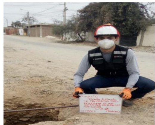
Excavación de calicata 02
