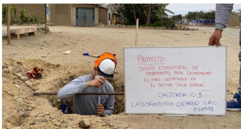
Excavación de calicata 03
