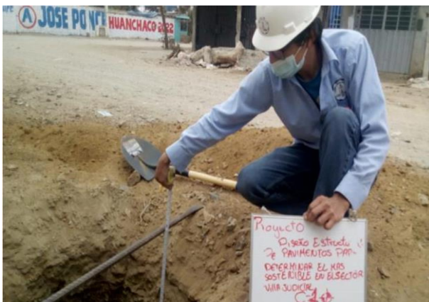
Excavación de calicata 01
