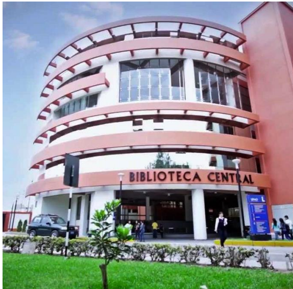
Imagen N° 36 Exterior Biblioteca Central UPAO
