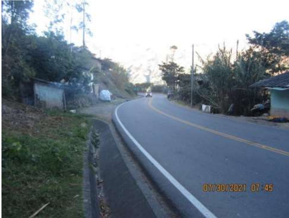
Figura N° 34: Las Bermas no cumplen con la dimensión mínima
