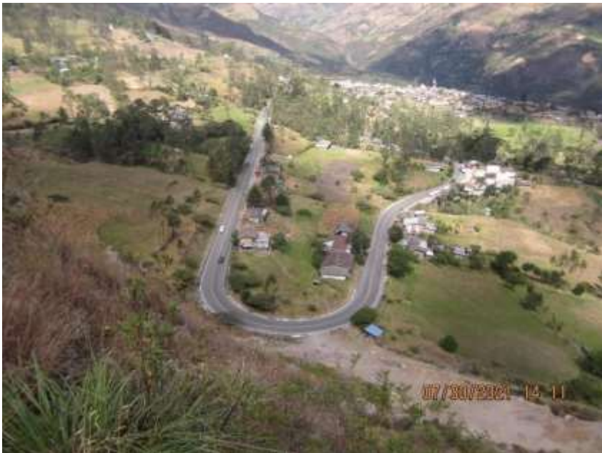
Figura N° 47: Tramos sucesivos de la carretera con velocidades de operación muy diferentes.
