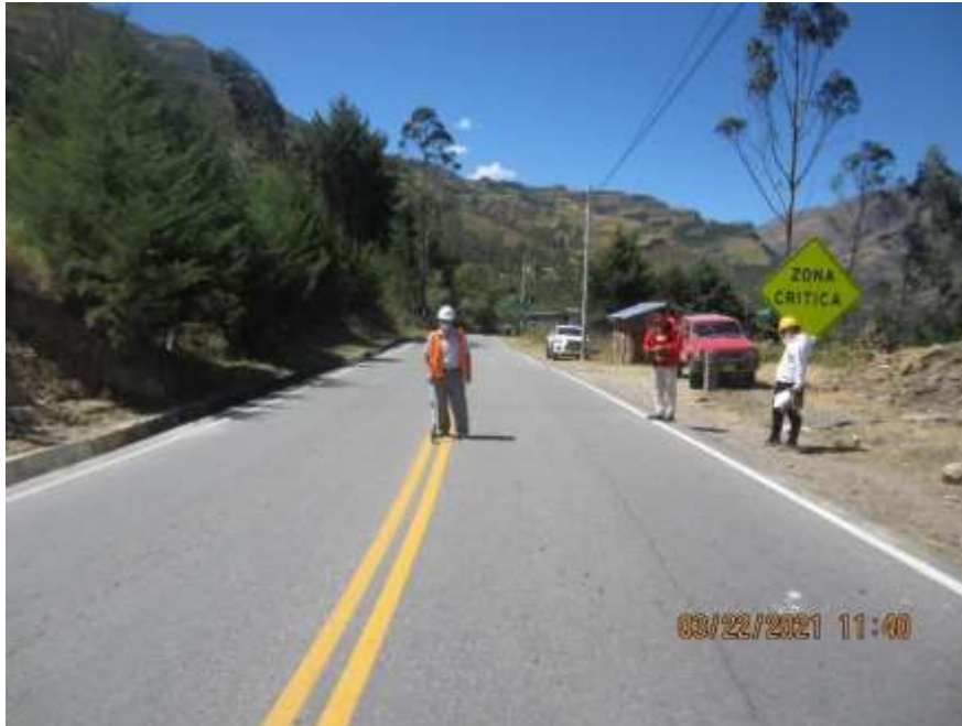
Figura N° 44: Verificación de las longitudes tramo en tangente.
