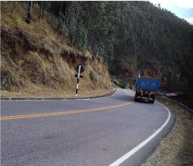
Figura N° 49: Ancho de la calzada no adecuado para el ancho del vehículo.
