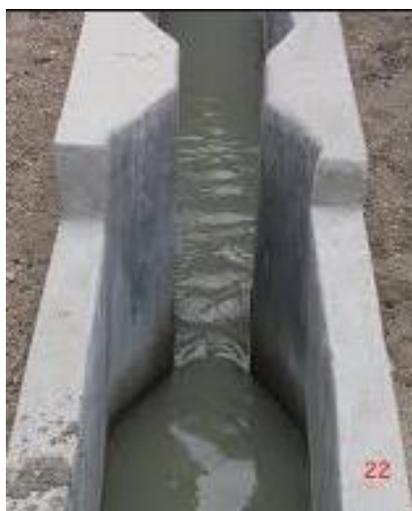
**Figura 18:** Canal de medición Parshall. *Fuente:* Elaboración propia.
