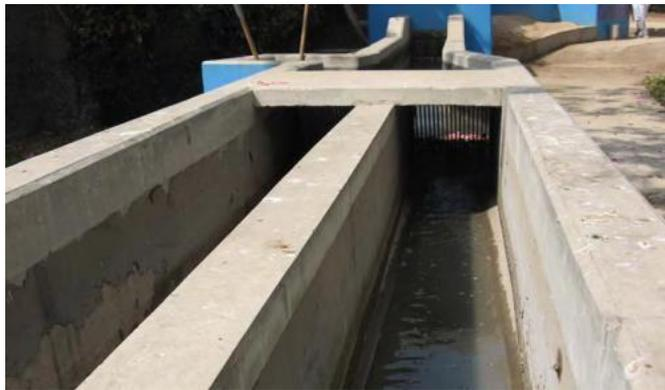
**Figura 17:** Cámara de desarenador. *Fuente:* Elaboración propia.
