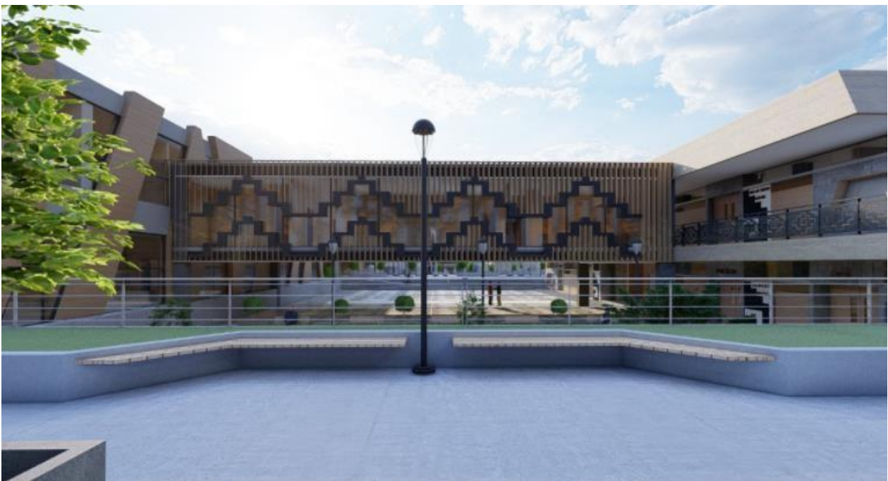
IMAGEN N° 125: Lamas de madera en la fachada - Escuela de Música.
