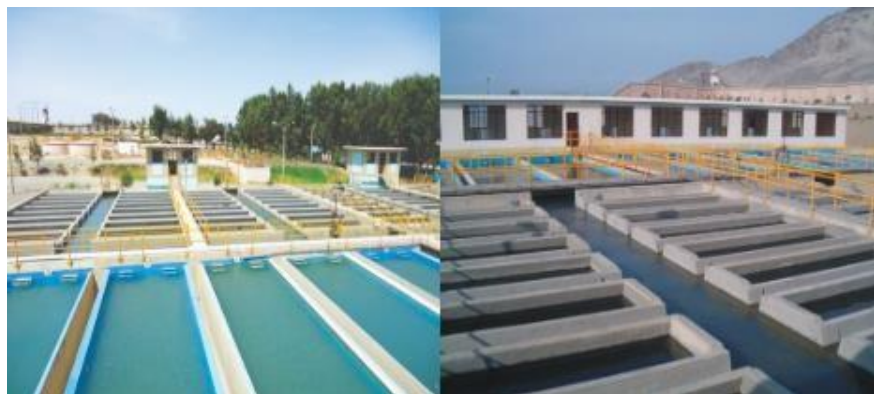
IMAGEN N° 56: Planta de tratamiento de agua potable.
