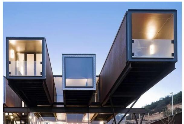
Casa ecológica construida con contenedores reciclados, con ventanas amplias para una buena iluminación y ventilación
