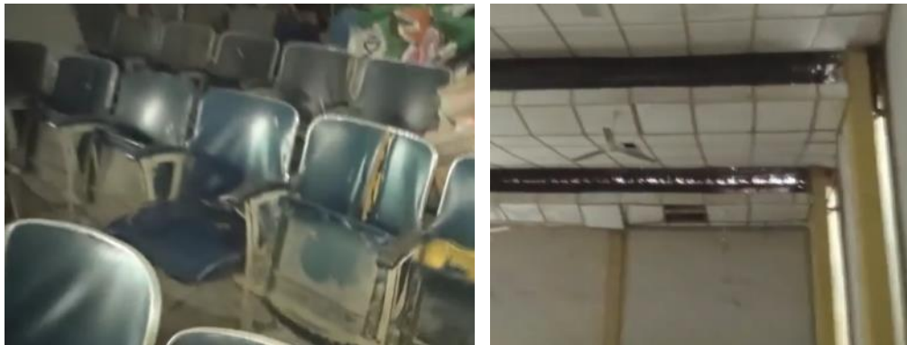
FIGURA N°57: VISTAS INTERIORES DEL TEATRO DE MADRE DE DIOS
