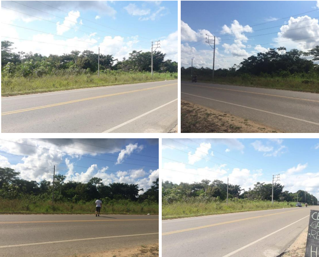
FIGURA N°72: VISTAS DEL TERRENO
