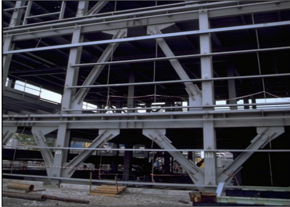
Figura 6 : Pórtico excéntricamente arriostrado.
