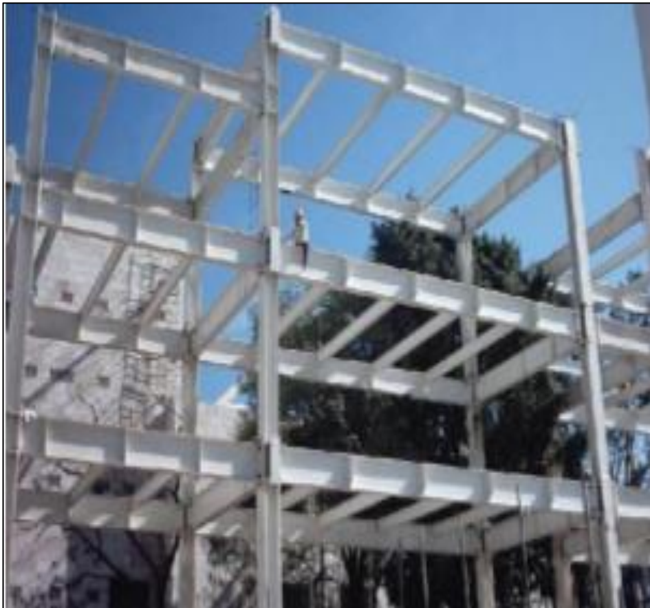
Figura 5 : Viga principal en pórticos.
