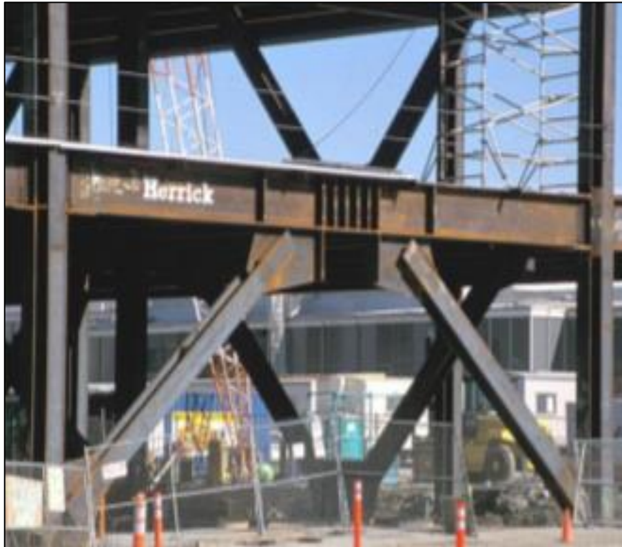
Figura 12 : Pórtico con arriostres excéntrico EBF
