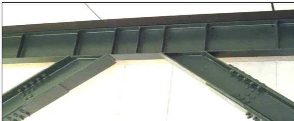
Figura 7 : Enlace o link en pórtico arriostrado excéntricamente.
