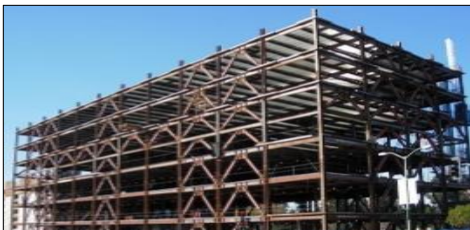
Figura 10 : Vista de un edificio con pórticos arriostrados.
