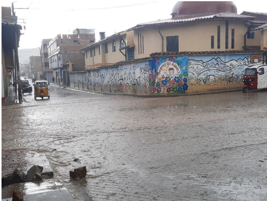
Figura 04: Encharcamiento en intersección de los Jirones Bolognesi y Alfonso Ugarte
